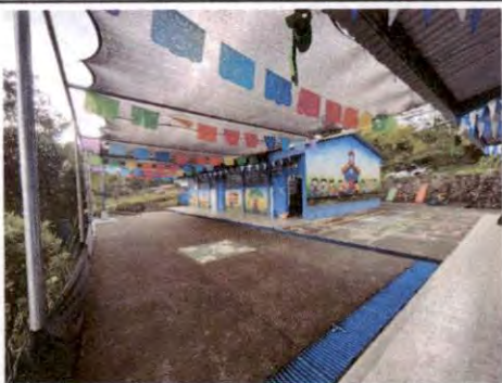
Foto1: Reforzamiento y pintura de estructura metálica, enlaminado
