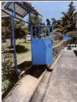
Foto 9: Suministro de rejilla en puerta de ingreso
