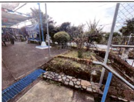
Foto 5: Suministro de baranda frente al jardín
