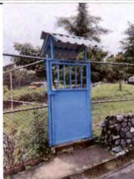
Foto 8: Mejoramiento puerta de ingreso con techo
