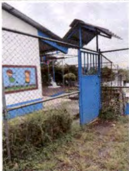
Foto 7: Mejoramiento puerta de ingreso con techo
