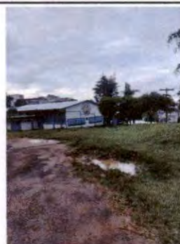
Foto 12: Suministro adoquin, Frente a puerta de ingreso
