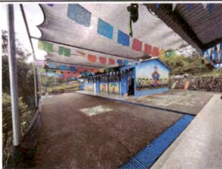
Foto 3: Canal con bajadas pluvial en techo de patio, Módulos A
