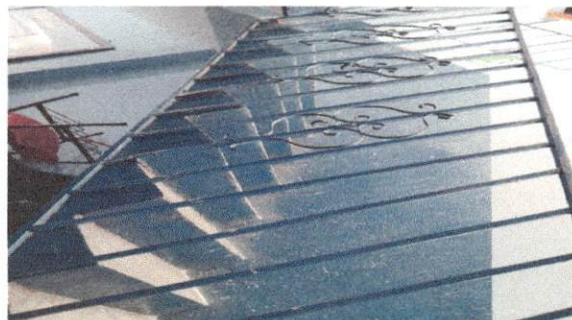
Foto 2: barandas segundo nivel
