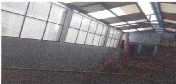
Foto 5: cambio de ventana
