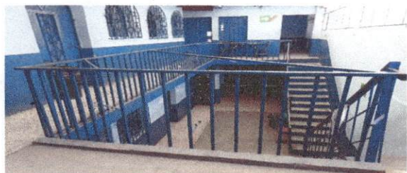
Foto1: Barandas segundo nivel
