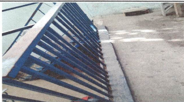
Foto 4 cambio de baranda segundo nivel
