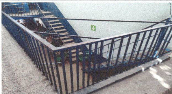
Foto 3: cambio de baranda segundo nivel
