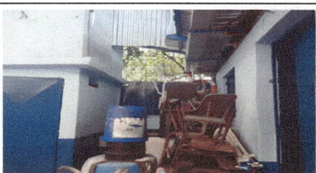
Foto 4: Instalación de depósito de agua
