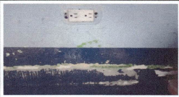
Foto 2: Pintura de paredes
