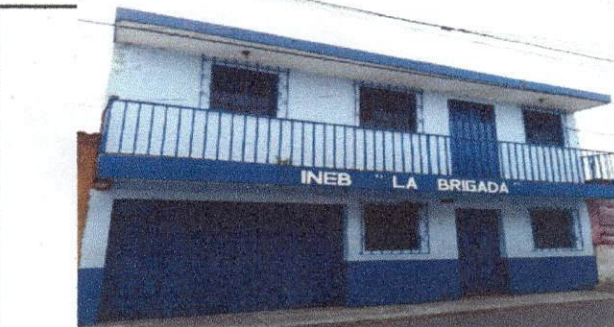
Foto 3: pintura de paredes, puertas y cielo falso
