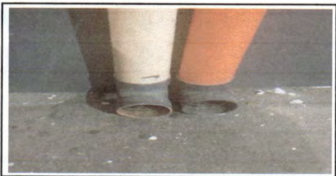
Foto 5: canales y bajadas de agua pluvial
