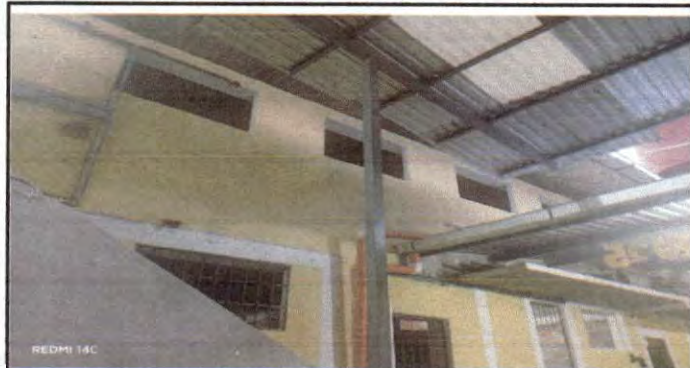
Foto1: colocación de balcones
