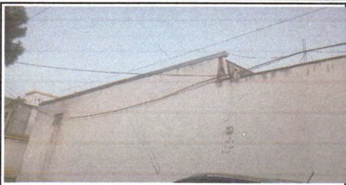
Foto 2: cambio de canales
