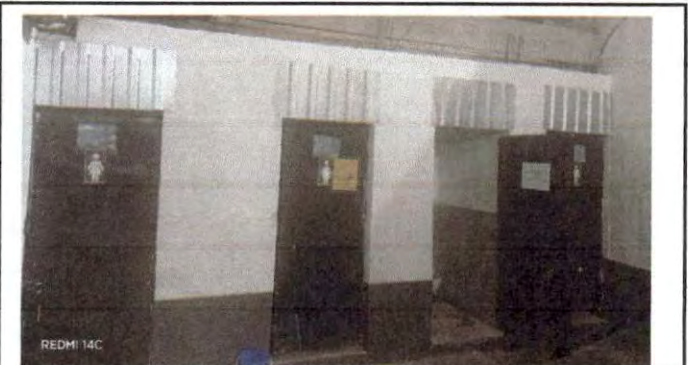
Foto 4: reparacion de puertas en sanitarios
