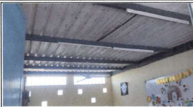
Foto 2: mantenimiento de costaneras, lijado y pintado con pintura anticorrosiva.
