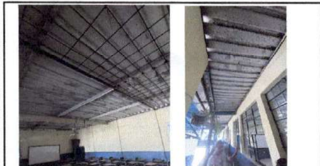
Foto 3: Sustitución de cubierta en modulo 1 de aulas
