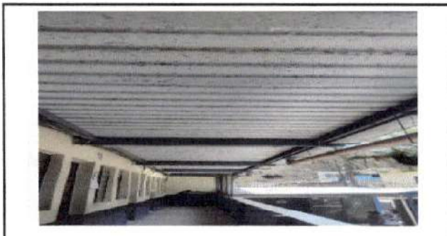
Foto 4: mantenimiento en costaneras, con aplicación de pintura anticorrosiva.
