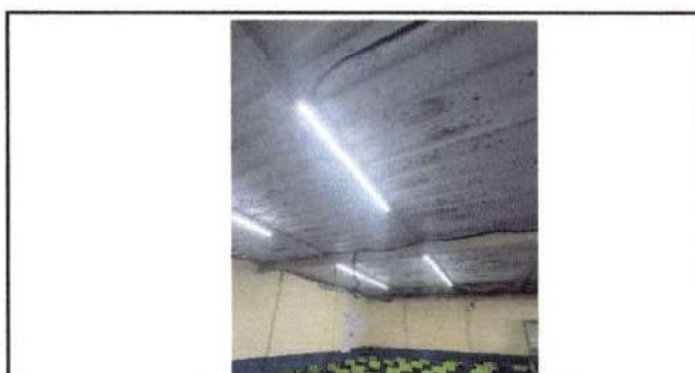
Foto 6: Sustitución de cubierta en modulo 1 de aulas
