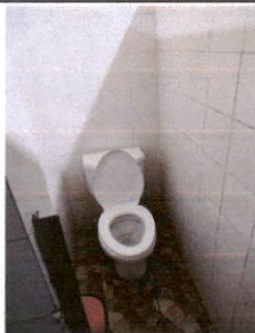
Foto 5: Dado de los sanitarios actuales son de uso doméstico, se tapan constantemente.
