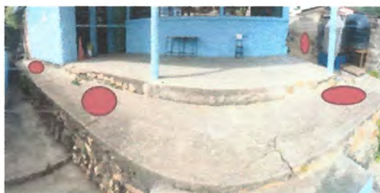
14.7 Instalación de reposaderas (con tubo de 3" con salida)
