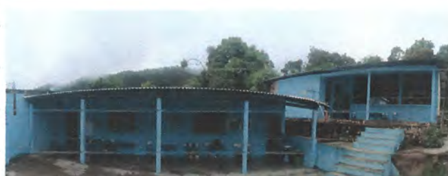
7.6 instalación de bajada de agua con tubo de 3 "
