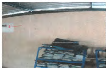
17.9 Sustitución de tablero de flipones
