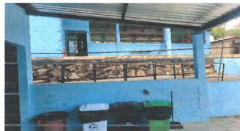
11.2 Sustitución de baranda de metal
