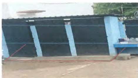
14.6 Limpieza de fosa séptica
