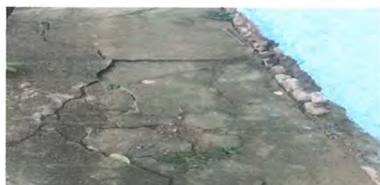
6.5 Sustitución de piso torta de concreto (para polletón)
