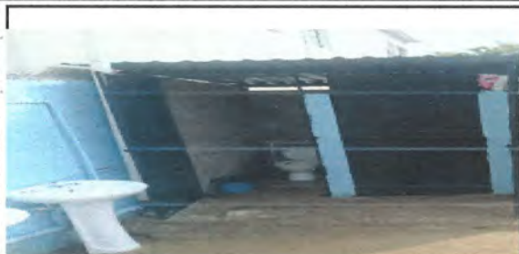
10.11 Cambio de mangueras de lavamanos (manguera de abasto y cintrallave)
