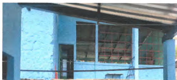
5.1 Mantenimiento a ventanas (instalacion de lámina lisa 1/16)
