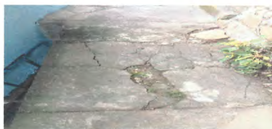
6.1 Reparacion de piso torta de concreto (para pila) 1.50x2
