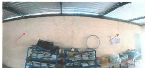
17.7 Sustitución de tomacorrientes (incluye ducto y cable)
