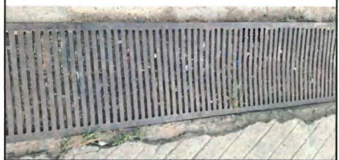
MATENIMIENTO DE REPOSADERAS DE PATIO
