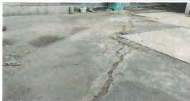
Foto 5: REPARACION DE TORTA DE CONCRETO PARA PATIO COMPARTAR, DEMOLICIÓN Y CERNIDO.
