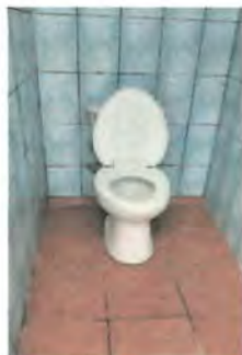
Foto 1: SUSTITUCIÓN DE SANITARIOS Y SUS ACCESORIOS.
