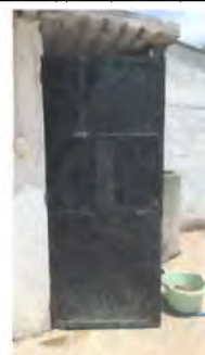
Foto 6: SUSTITUCION DE PUERTAS DE METAL
