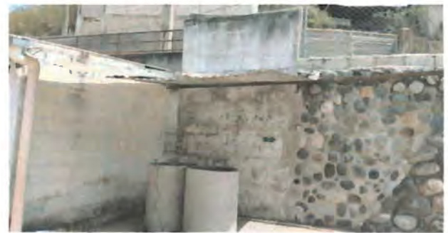
SUSTITUCIÓN DE LÁMINA.
