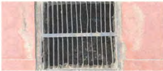
FOTO3: MATENIMIENTO DE REPOSADERAS DE PATIO.
