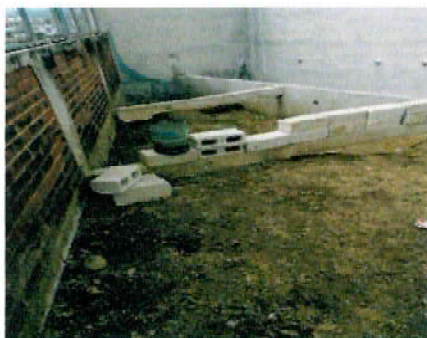
Instalación de torta de concreto al lado de la entrada principal
