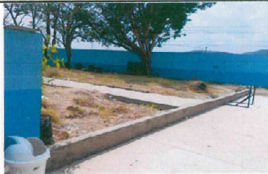
16.1 Colocación de losa de patio con dos gradas en orilla de patio/cancha.
