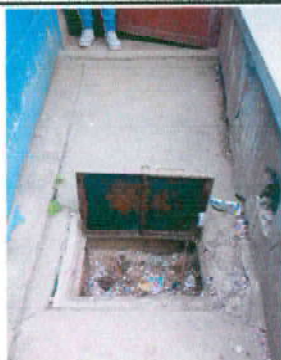
14.1 Sustitución de llave principal de agua potable
