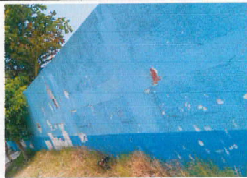
22.1 Cernido de Muro exterior tipo vertical
