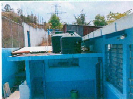
11 Impermeabilización de losa
