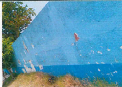
9.1 Pintura de muro exterior
