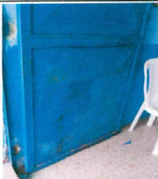
4.1 Mantenimiento de puertas de metal
