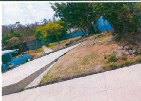
16.1 Colocación de losa de patio de 10cm de grosor con electromaya
