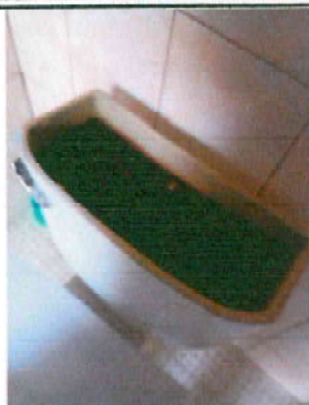
10.2 Sustitución de accesorios de sanitario.
