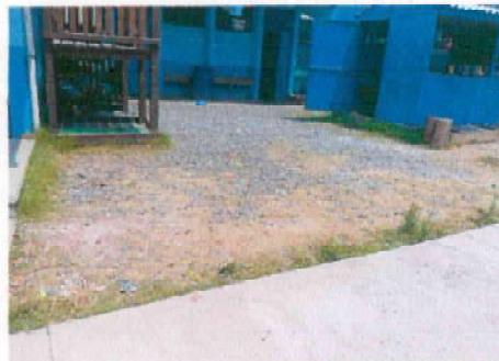
16.1 Rebaje de suelo y Colocación de losa de patio de 10cm de grosor con electromaya
