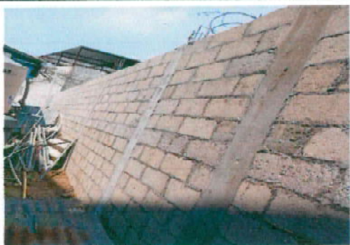
5.1 Colocalónn de Razer sobre muro perimetral
