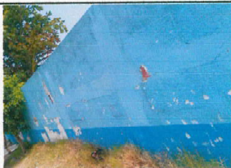
9.1 Pintura de muro exterior
