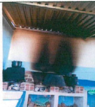
20.6 Colocación de chimenea de metal de 1 x 2 mts.
