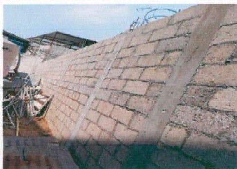
21.2 Cernido de muro perimetral tipo remolinado.
