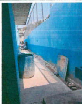
19.6 Sustitución de puerta de metal tipo reja.
