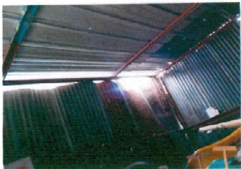
5.2 Realización de ventanas de metal corredeizas 1 x 1.5mts
