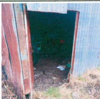
6.5 Sustitucion de piso a concreto
