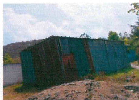
1.1 Sustitución de aula de lamina acanalada a lamina troquelada
