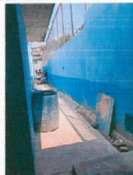
19.6 Sustitución de puerta de metal tipo reja.
