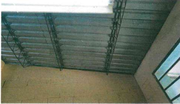
1.1 Sustitución de 1 lámina en el primera aula del segundo nivel
