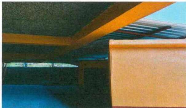
2.1 Instalación de estructura de soporte en área de patio frente a la cocina.
