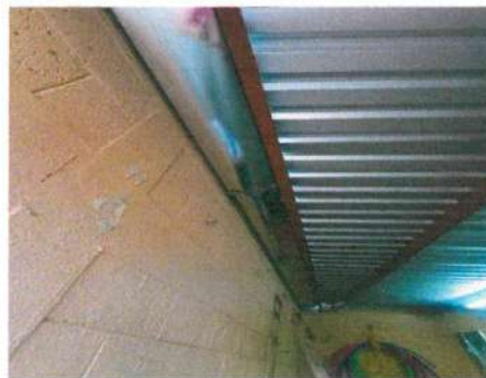
7.1 Sustitución de 3 canales cuadrangulares en bodega No. 1
