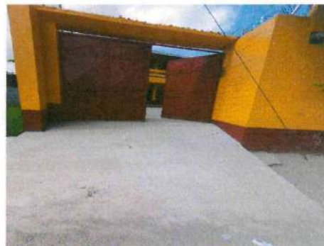
8.2 Sustitución de banqueta de concreto en la entrada principal
