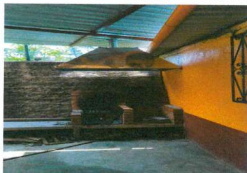
20.1 Realización de estufa rural con 2 planchas de concreto y chimenea
