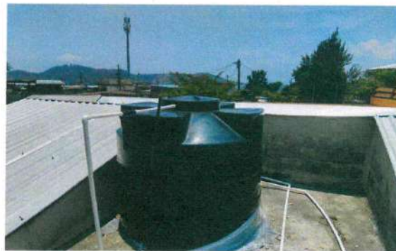
18.1 Suministro e instalación de deposito de agua
