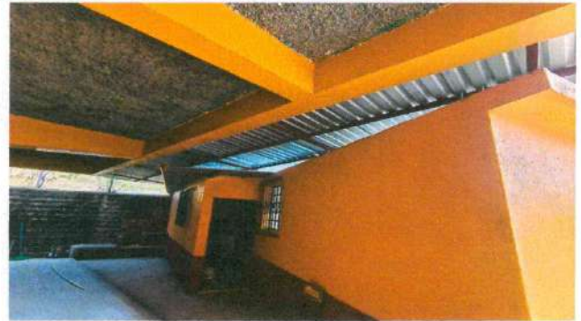
1.1 Sustitución de láminas en techado frente a la cocina.
