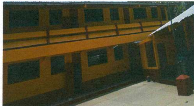
4.1 Mantenimiento de 9 puertas (7 en salones, 1 dirección y 1 en bodega de atrás de dirección)
