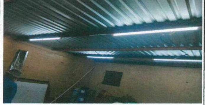
1.1 Sustitución de láminas troqueladas en bodega No.1 atrás de la dirección.
