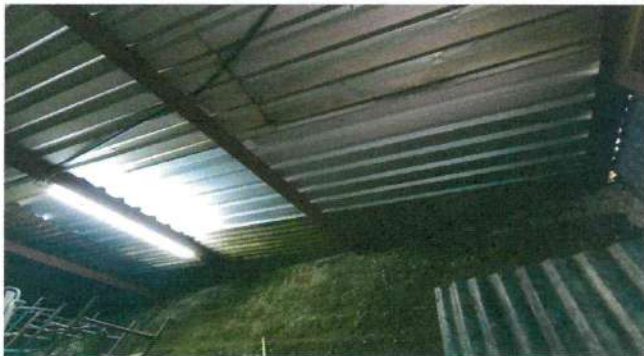
1.1 Sustitución de láminas en bodega No. 2
