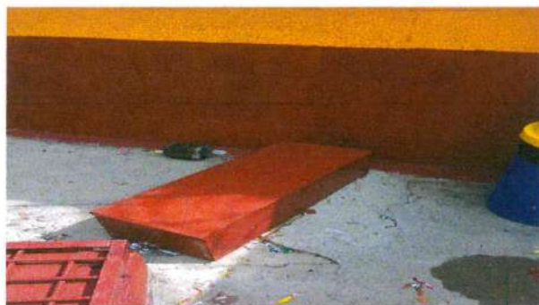
14.5 Realización de caja de metal para llaves de agua potable
