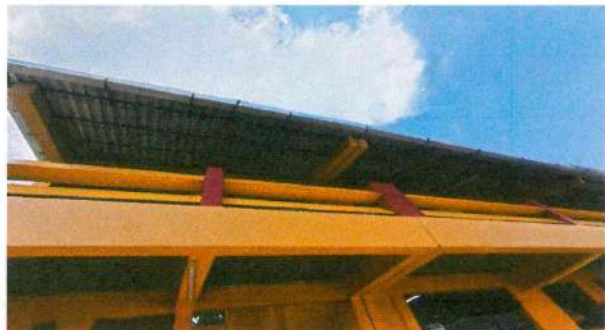
7.1 Sustitución de 5 canales en el techo segundo nivel
