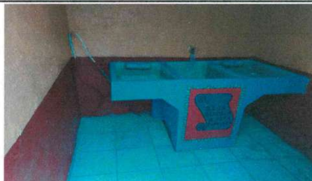
14.3 Sustitución de tubería de drenaje de la candela hacia la pila
