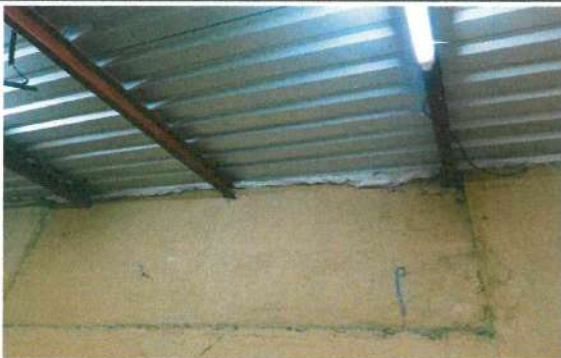
1.1 Compostura de fuga de techo bodega No. con sika flex
