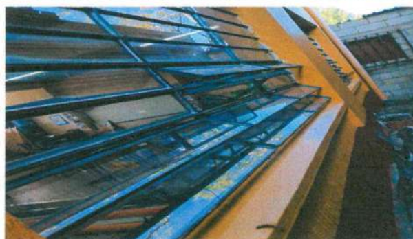
5.5 Sustitución de 68 vidrios en aulas
