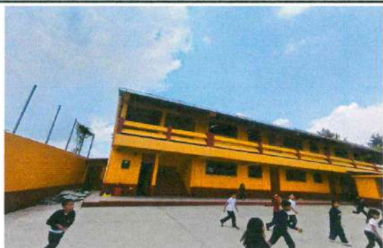
9.1 Aplicación de pintura en los muros exteriores
