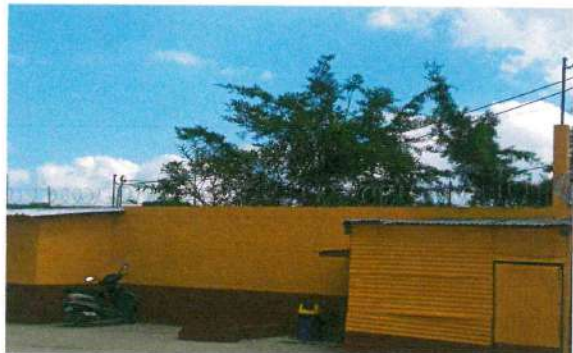
15.4 Instalación de alambre rizo ribbon en muro perimetral
