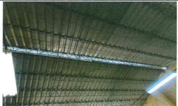
1.2 Sustitución de capote troquelado en techo de segundo nivel
