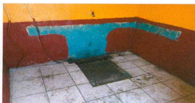
14.3 Sustitución de tubería de drenaje de la candela hacia la pila
