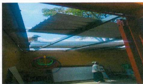
1.1 Sustitución de láminas troqueladas en bodega No.1 atrás de la dirección.
