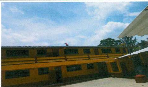
1.2 Sustitución de capote troquelado en techo de segundo nivel
