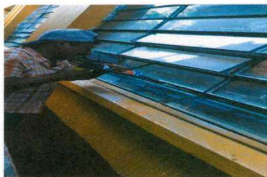
5.5 Sustitución de 68 vidrios en aulas
