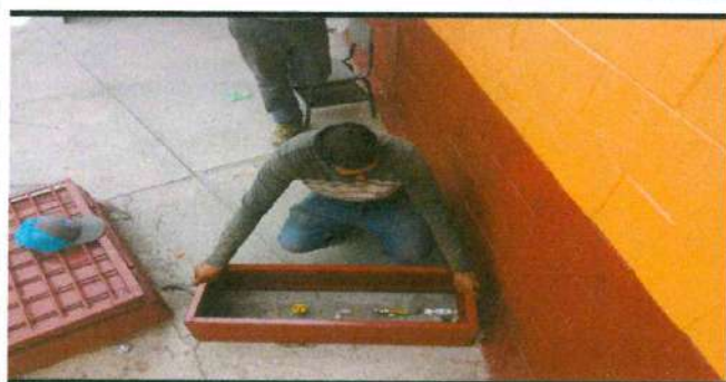
14.5 Realización de caja de metal para llaves de agua potable
