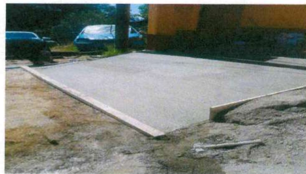
8.2 Sustitución de banqueta de concreto en la entrada principal
