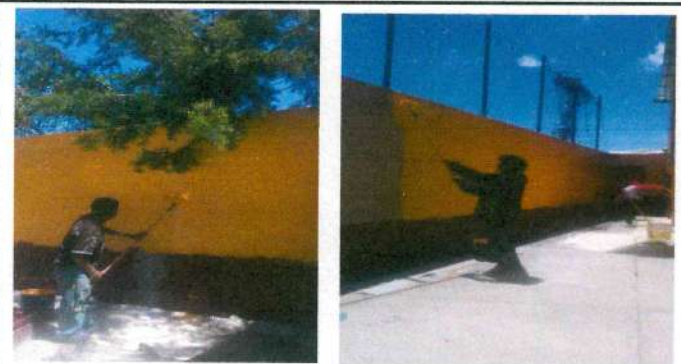
9.1 Aplicación de pintura en los muros exteriores
