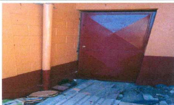
4.2 Sustitución de chapa en puerta de bodega No. 1
