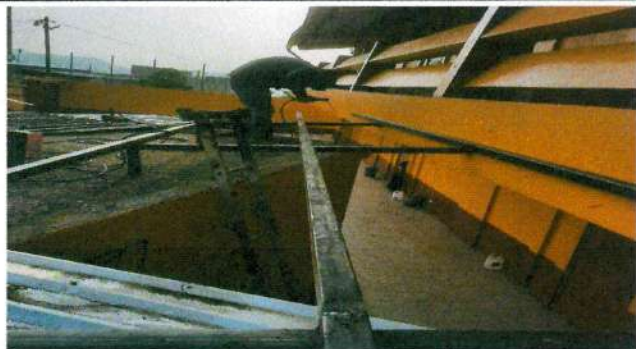
2.1 Instalación de estructura de soporte en área de patio frente a la cocina.
