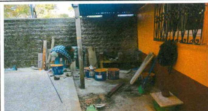
20.1 Realización de estufa rural con 2 planchas de concreto y chimenea
