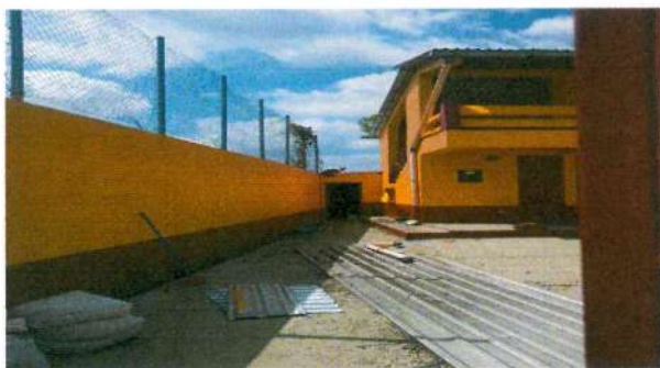
1.1 Compostura de fuga de techo bodega No. con sika flex
