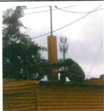
15.4 Instalación de alambre rizo ribbon en muro perimetral
