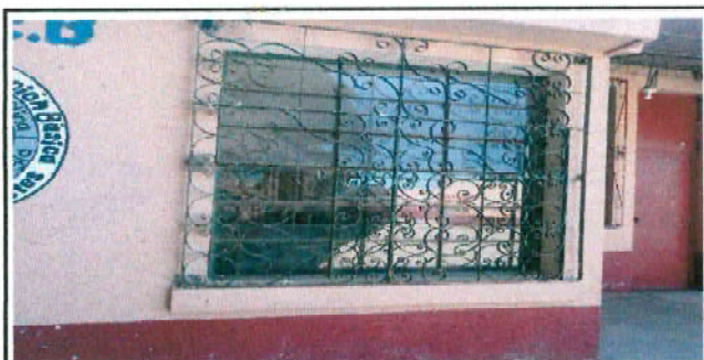
Foto 5: MANTENIMIENTO DE BALCÓN DE METAL EN DIRECCIÓN VESPERTINA
