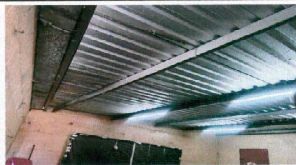
Foto 4: COMPOSTURA DE FUGA EN BODEGA # 1
