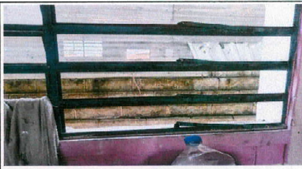
Foto 4: MANTENIMIENTO DE VIDRIOS EN PRIMER Y SEGUNDO NIVEL DE LOS SALONES
