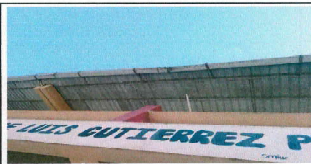
Foto 6: SUSTITUCIÓN DE CANALES DE METAL EN TECHO DE SEGUNDO NIVEL
