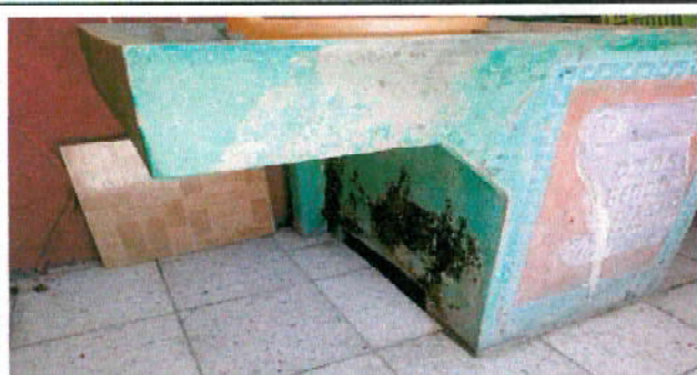
Foto 3: SUSTITUCIÓN DE TUBERIA DE DRENAJE HACIA LA PILA
