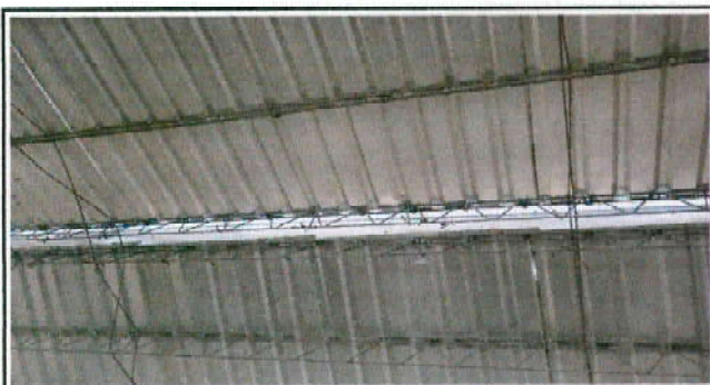
Foto 3: SUSTITUCIÓN DE CAPOTE EN EL TECHO DEL SEGUNDO NIVEL
