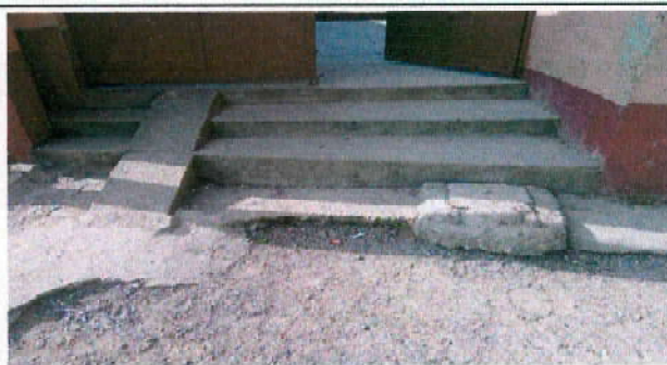
Foto 2: SUSTITUCIÓN DE BANQUETA DE CONCRETO
