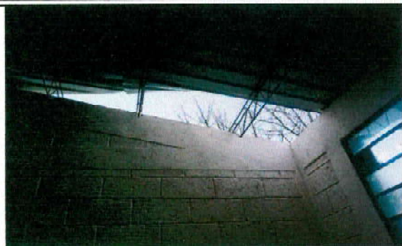
Foto 1: SUSTITUCIÓN DE LÁMINA EN TECHO DE 1RA AULA DE SEGUNDO NIVEL
