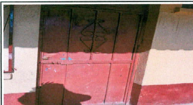
Foto 3: MANTENIMIENTO A ESTRUCTURA DE 9 PUERTAS, CAMBIO DE CHAPA YALE EN BODEGA #1
