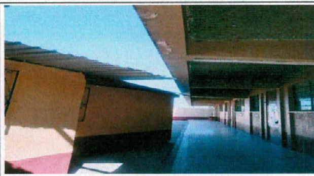
Foto 2: SUSTITUCIÓN E INSTALACIÓN DE ESTRUCTURA Y DE LÁMINA FRENTE A LA COCINA
