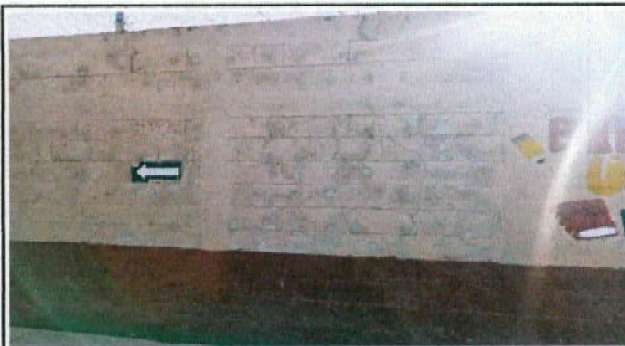
Foto 4: MANTENIMIENTO PINTURA EN MUROS EXTERIORES EN PRIMER, SEGUNDO NIVEL Y MURO PERIMETRAL
