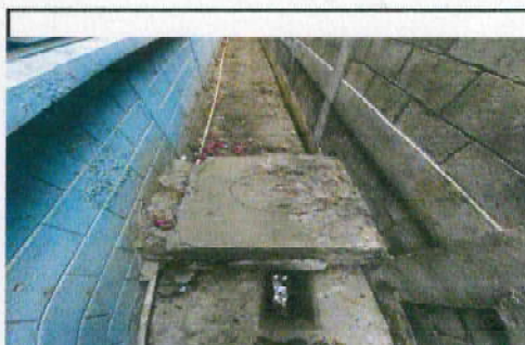
Foto 4: 14.8 Sustitución de caja de registro.
