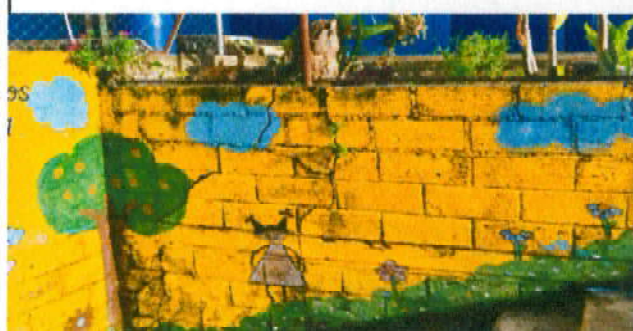
Foto 1: 22.1 Reparación de muro de contención
