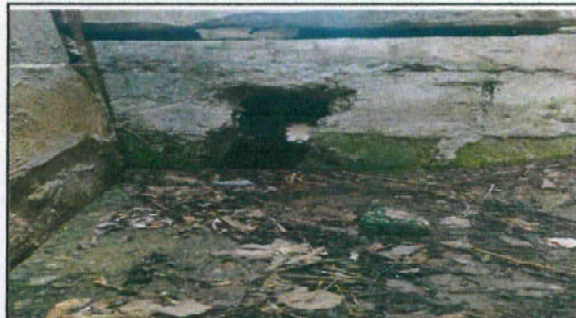
Foto 2: 14.3 Sustitución de tubería PVC línea principal de aguas negras.
