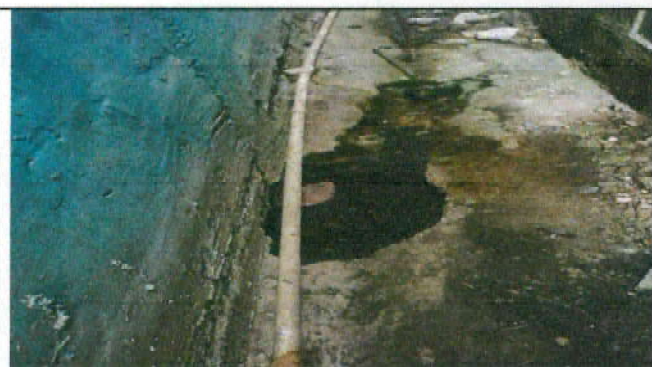
Foto 3: 14.3 Sustitución de tubería PVC línea principal aguas
