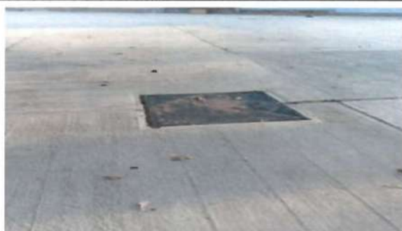
REUBICACION DE TINACO
