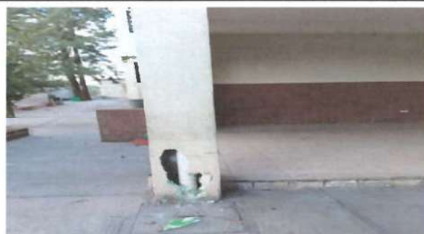
REPARACION DE BAJADAS DE AGUA PLUVIAL
