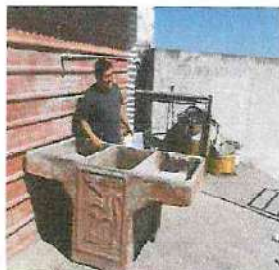
Foto1: Instalación de pila
