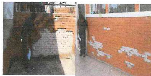
Foto 2: Mantenimiento de fachaleta
