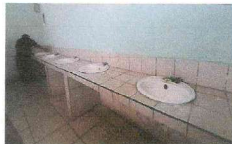
Foto 2: Mantenimiento de Lavamanos
