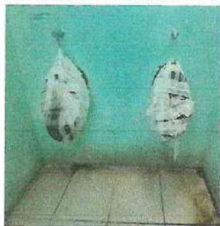
Foto1: Mantenimiento de Sanitarios
