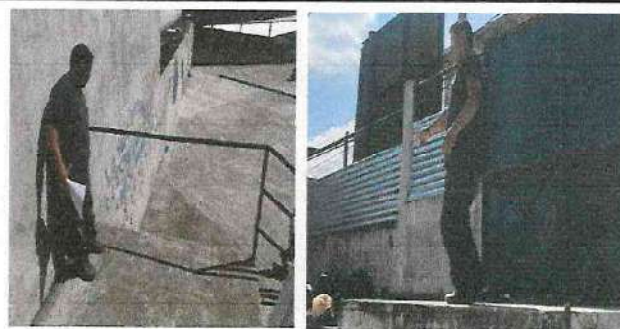
Foto 6: pasamanos y barandas de grada
