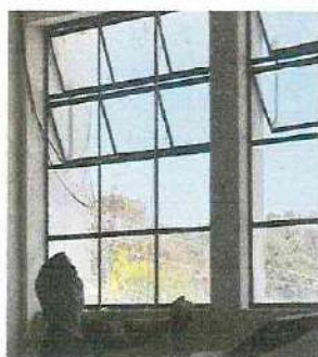
Foto 3: Mantenimiento de ventanas
