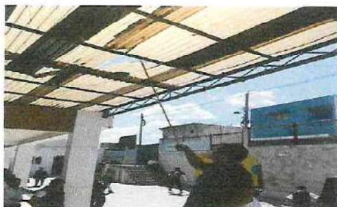
Foto 5: cambio de laminas
