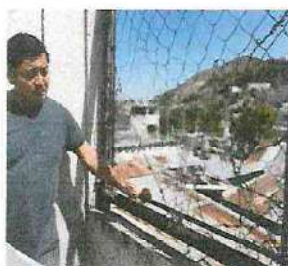
Foto 3: Mantenimiento de malla
