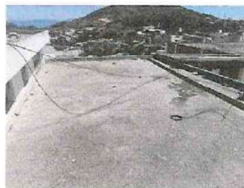
Foto 2: Instalación de tinaco
