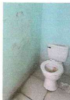
Foto 4: Mantenimiento de sanitarios
