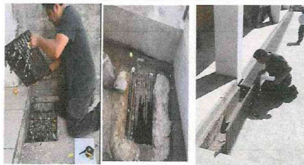
Foto 4: Drenajes e instalacion de agua
