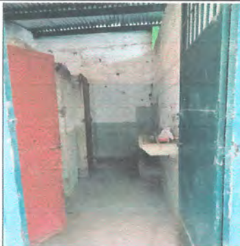
Foto 1 SUSTITUCIÓN DE INODORO Y ACCESORIOS
