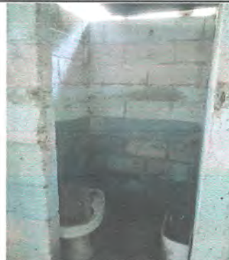
Foto 2 SUSTITUCIÓN DE MIGITORIO Y ACCESORIOS
