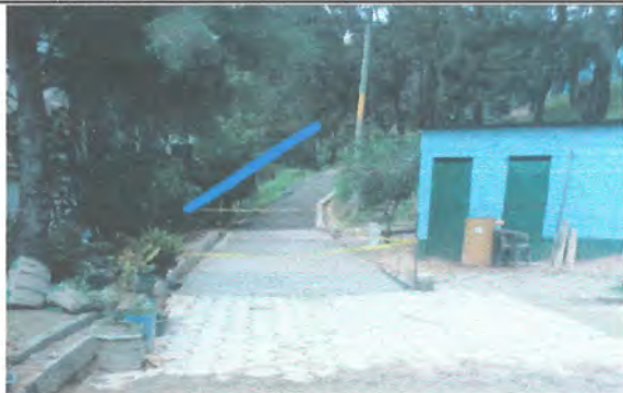
FOTO 1 SUSTITUCION DE CUNETA PARA ENTRADA DE LA ESCUELA 46.6 MTS LINEALES DEL LADO IZQUIERDO A LA PAR DE LA LOZA DE CONCRETO PARA EVITAR DESBORDE.
