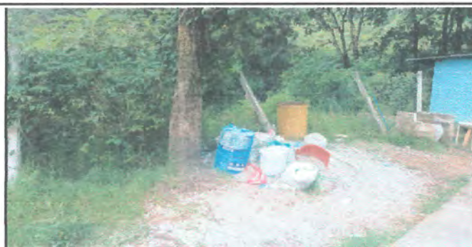
Foto 5: DESINSTALACIÓN DE MALLA CON 3 METROS DE ALTO CON TUBO DE 2 METROS
