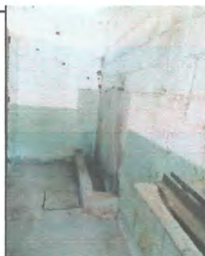
Foto 3 SE QUITARÁ LO QUE ESTA AL FONDO PORQUE SE PONDRA UN MIGITORIO EN DONDE ESTAN LOS SANITARIOS
