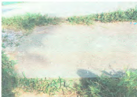
FOTO 2 SUSTITUCIÓN DE LOZA DE CONCRETO ENTRADA DE LA ESCUELA 133 MTS2 CON ELECTROMAYA DE 8 MM
