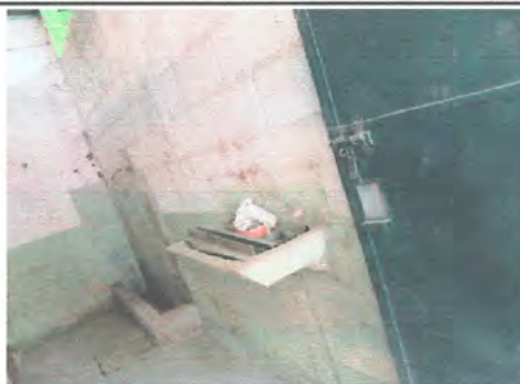
Foto 4 SUSTITUCIÓN DE LAVAMANOS
