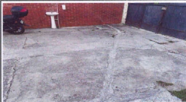
Foto 2: 6.1 REPARACION DE TORTA DE CONCRETO
