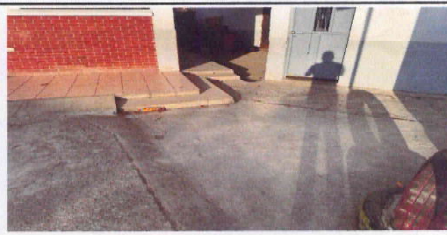
Foto 4: 6.1 REPARACION DE TORTA DE CONCRETO
