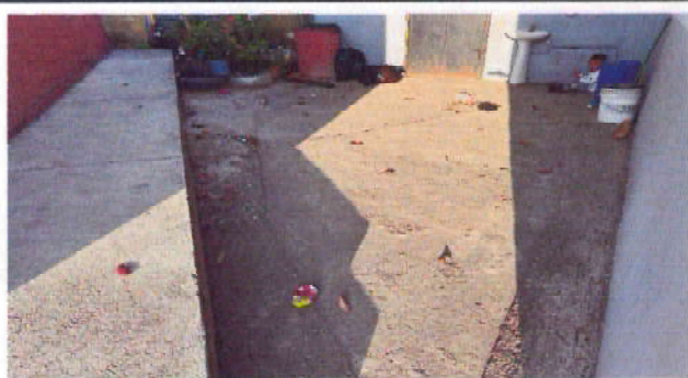
Foto 5: 6.1 REPARACION DE TORTA DE CONCRETO
