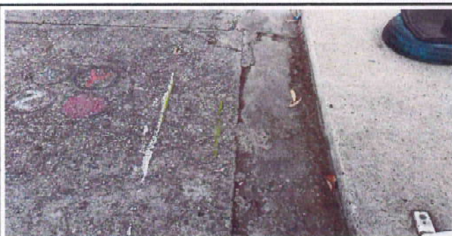
Foto 3: 6.1 REPARACION DE TORTA DE CONCRETO
