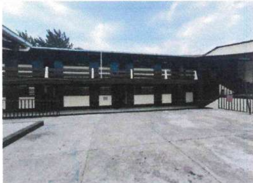
Foto1: Vista general modulo escuela.
