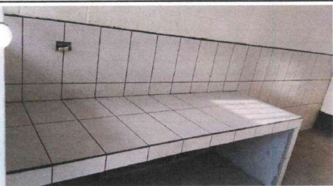
Foto 4: Elaboración de ensimera de concreto en área de cocina
