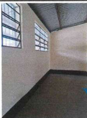
Foto 3: Paredes exterior salones de clases primer nivel.
