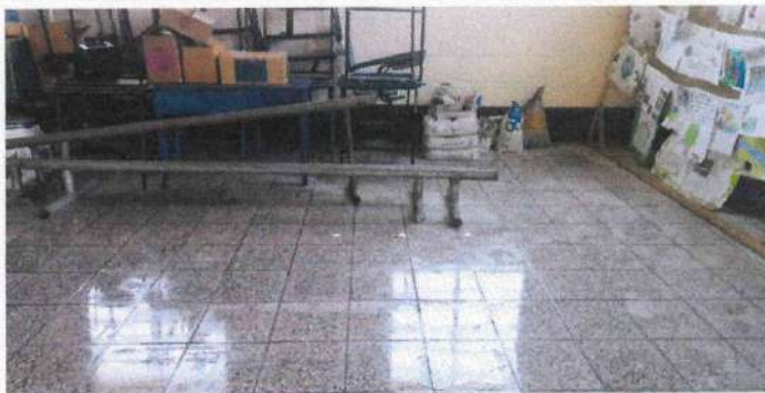
Foto 4. Suministro e instalación de piso de granito.
