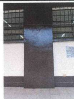
Foto 6: Pintura de cerca primer nivel.
