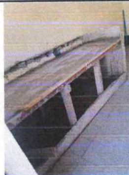
Foto 4: Elaboración de ensimera de concreto en área de cocina
