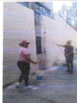
Foto 6: Pintura muro perimetral
