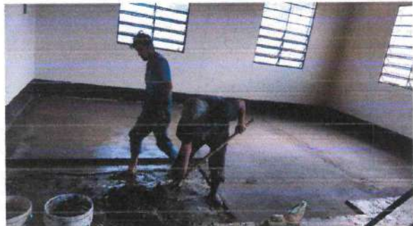
Foto 4. Suministro e instalación de piso de granito.
