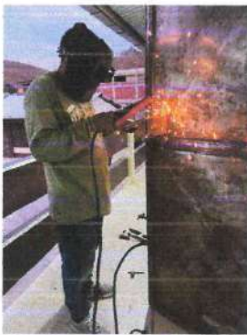
Foto 3: Cambio de chapa 5to. Primario
