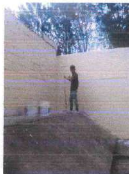
Foto 4: Muro perimetral interior escuela.
