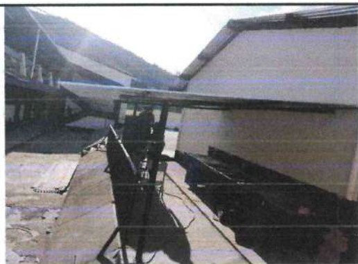
Foto 3: Cambio de techo y ampliación del mismo área de pilas
