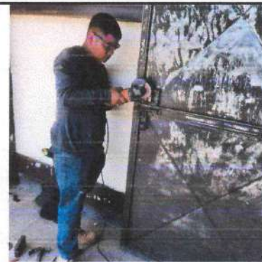
Foto 4: Cambio de chapa salon 5to. Primaria
