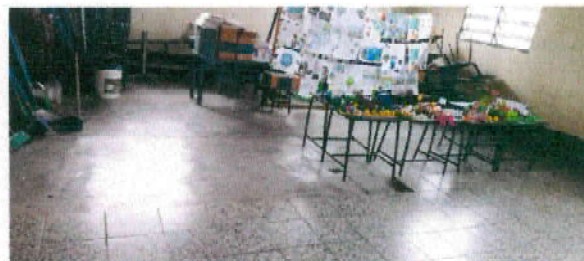
Foto 4. Suministro e instalación de piso de granito.
