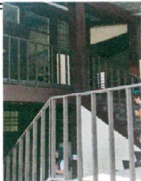
Foto1: Elaboracion de puerta y baranda para el segundo nivel
