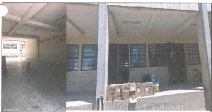
Pintura de pared de exteriores, entrada Principal, Fabricacion e intalacion de balcon nivel 1, modulo 2
