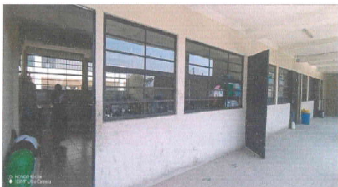
FOTO 10: Puerta mantenimiento a estructura lijado, cambio de tubo , cepillado, sujeciones, aplicación de pintura modulos 2, NIVEL 2, pintura de pared de exterior,NIVEL 2, MODULO 2 + balcones de ventana
