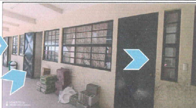
FOTO 8: Puerta mantenimiento a estructura lijado, cambio de tubo , cepillado, sujeciones, aplicación de pintura modulos 2+ pintura de exterior y balcones de ventanas
