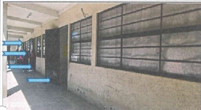
FOTO 7: Puerta mantenimiento a estructura lijado, cambio de tubo , cepillado, sujeciones, aplicación de pintura modulos 1 + Pintura de exterior+ balcones de ventanas, MODULO 1 NIVEL 2
