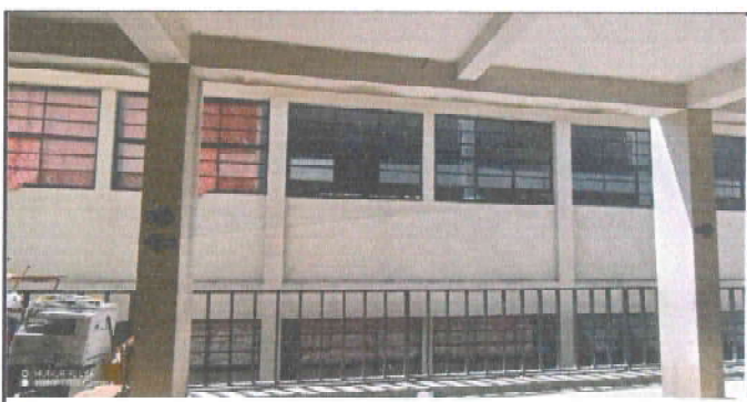
Balcones de ventana Modulo 2 exterior nivel 2
