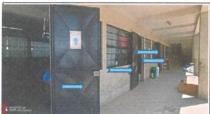
FOTO 9: Puerta mantenimiento a estructura lijado, cambio de tubo , cepillado, sujeciones, aplicación de pintura modulos 2, NIVEL 1, pintura de pared de exterior, + balcones de ventana
