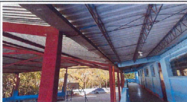
Foto 3: 7 CANALES Y BAJADAS DE AGUA PLUBIAL
