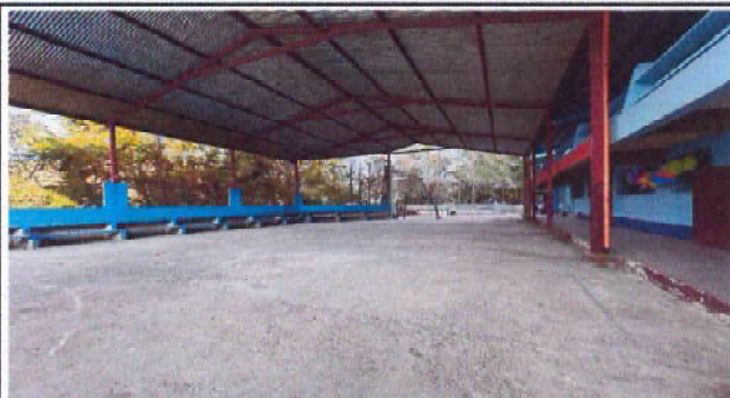
Foto 1: 1.1 REPARACION DE TORTA DE CONCRETO
