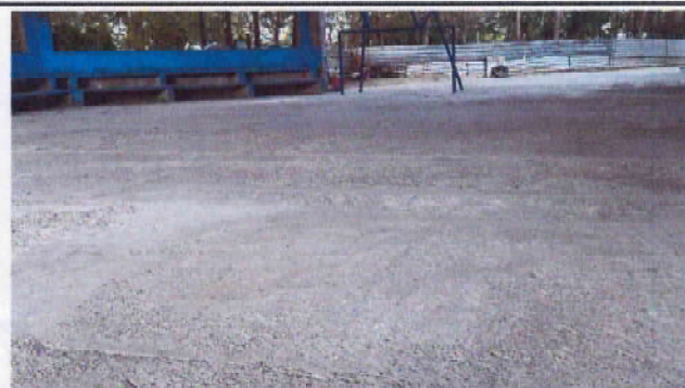
Foto 2: REPARACION DE TORTA DE CONCRETO
