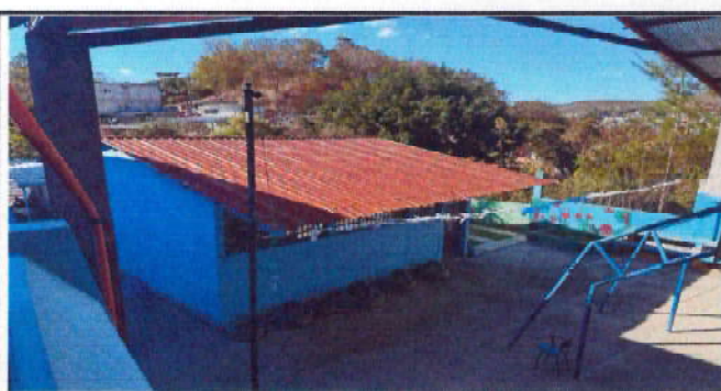
Foto 5: 1.1 SUSTITUCION DE LAMINA, POR LAMINA TROQUELA CON ALUCIN CALIBRE 26
