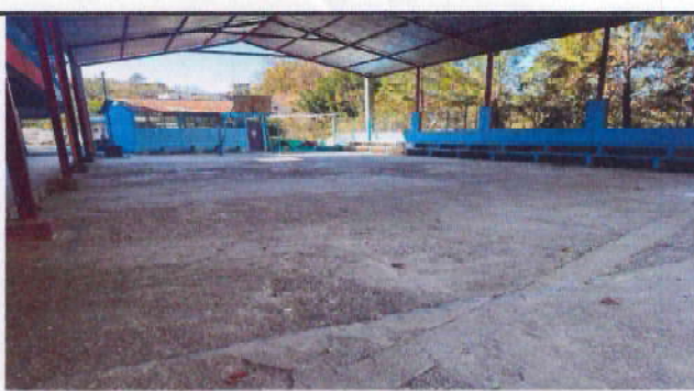
Foto 6: 1.1 SUSTITUCION DE LAMINA, POR LAMINA TROQUELA CON ALUCIN CALIBRE 26
