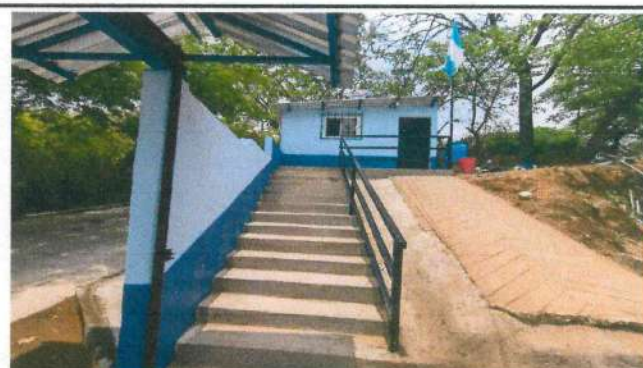
Foto 4: Sustrucción de banqueta de concreto frente a la cocina, por gradas de concreto de uno cincuenta de ancho por siete metros de largo.
