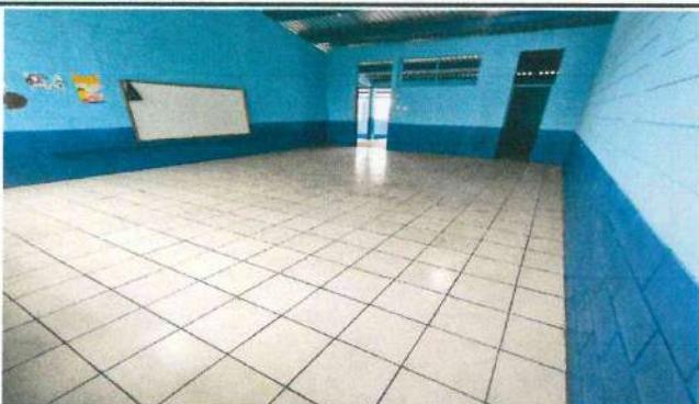
Foto 3: Sustrucción de piso de concreto en dos aulas, cocina y parte de corredor.
