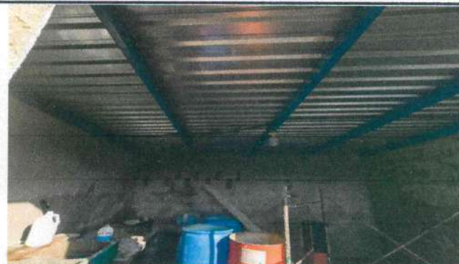
Foto 2: Mantenimiento a estructura de soporte de metal de cocina. (desmontado, lijado y pintado)
