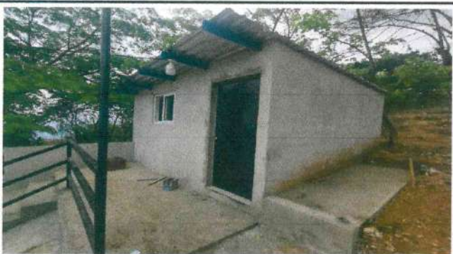
Foto 5: Reparación de partes de muro perimetral de block en la parte de afuera con aplicación de cernido en muro y cocina.
