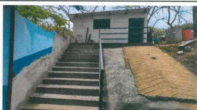
Foto 4: Sustitución de banqueta de concreto frente a la cocina, por gradas de concreto de uno cincuenta de ancho por siete metros de largo.
