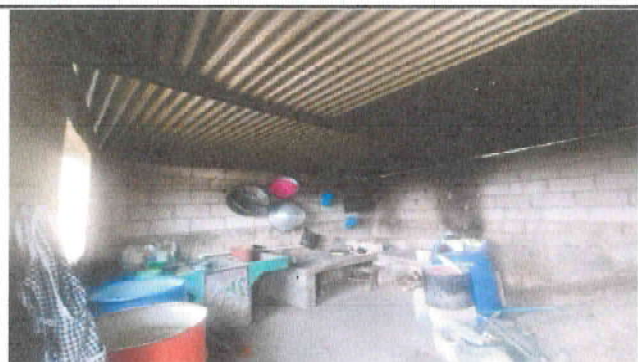
Foto1: Sustitución de lámina, por lámina troquelada alizinc calibre 26 para cocina.
