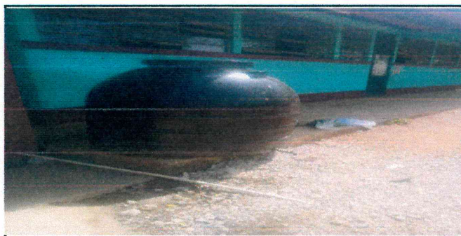
Foto 5: Sustitucion de deposito de agua
