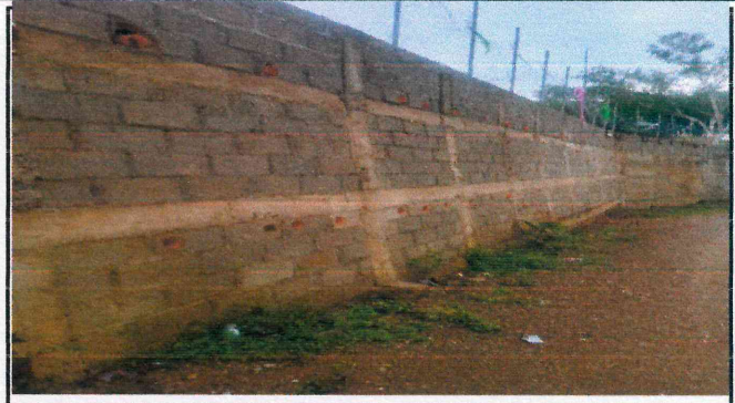
Foto 8: Repello de muro de contención
