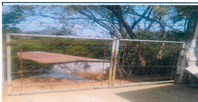
Foto 6: fabricacion e instalacion de porton de metal de ingreso
