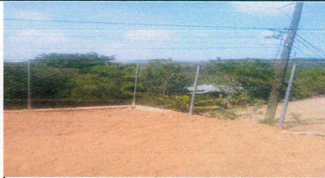
Foto 2: Reparacion y sustitucion de malla de de por una mas alta con block
