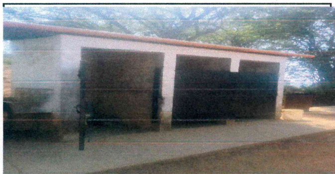
Foto 3: Mantenimientona Estructura lijado y napplication de pintura a puerta y paredes de sanitarios
