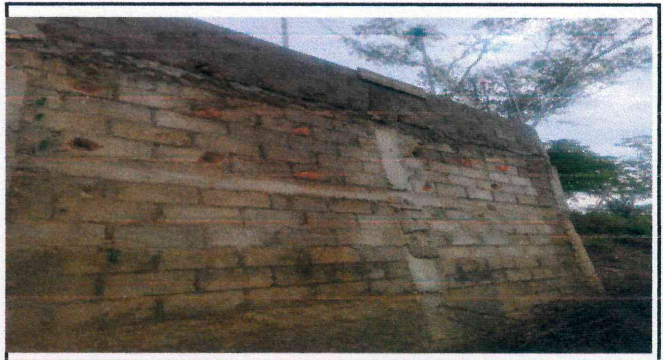
Foto 10: Repello de Muro
