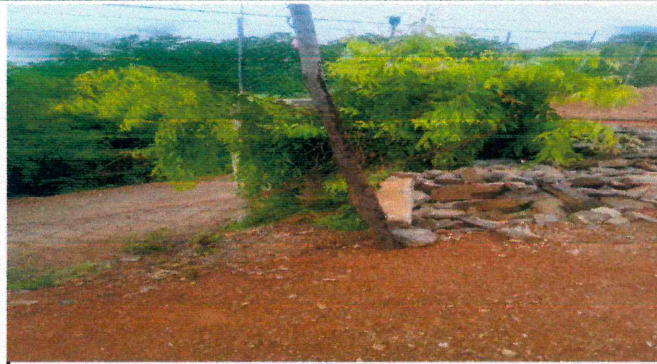
Foto 7 Sustrucción de malla por malla galvanizada con tubos hg
