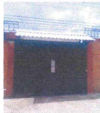
Foto 4: Techado de Porton
