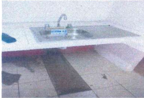
Foto1: Colocacion de lavatrastes
