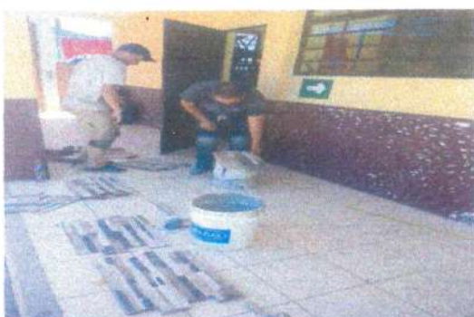
Foto 3: Colocacion de fachaleta
