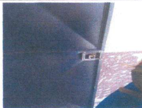
Foto 4: Colocacion de chapas
