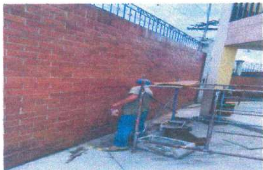
Foto1: Barnización de muro
