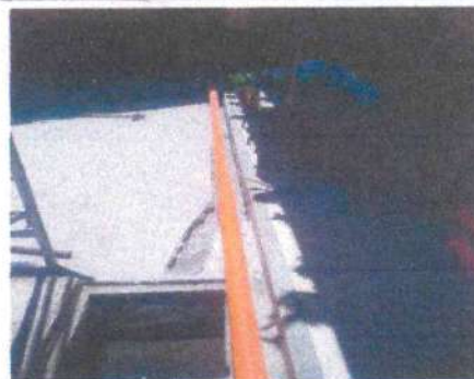
Foto 6: Instalacion de drenaje para lavatrastes
