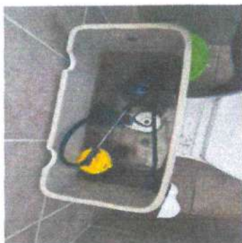
Foto 5: Reparacion de inodoro
