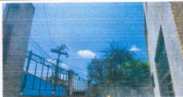
Foto 2: Levantamiento de muro perimetral
