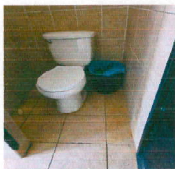
Foto 5: Mantenimiento de Baños
