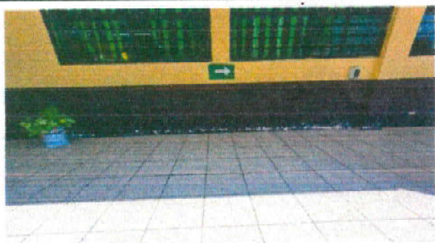
Foto1: Colocacion de fachaleta
