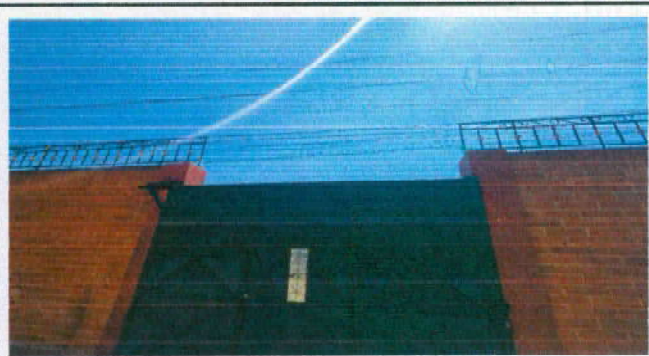
Foto 4: Reparacion de porton y pestañia
