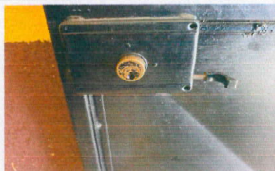
Foto 6: Reparacion de Chapas
