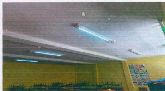
Foto 2: Reparacion de Lamparas
