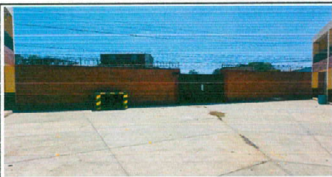
Foto 3: Continuidad del muro perimetral
