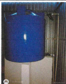
18.1 trabajo finalizado de instalación de tinaco y conducción de hacia las pilas.
