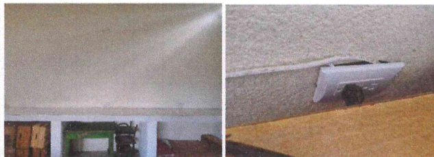
17.1 trabajo finalizado de reparación de sistema eléctrico
