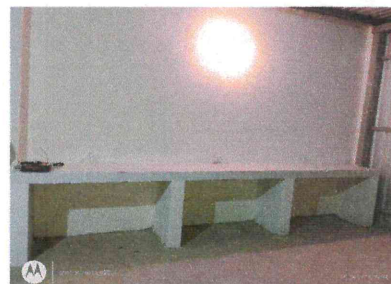
20.14 Trabajo finalizado de la reparación de cocina.
