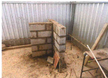
18.1 Construcción de base de concreto.
