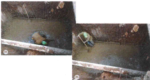
14.3 Fundición de losa para la reparación de fosa séptica
