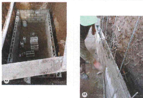
14.6.1 Construcción de muro de fosa séptica.
