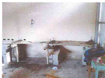
Foto 4: colocacion de base de madera para su fundicion.
