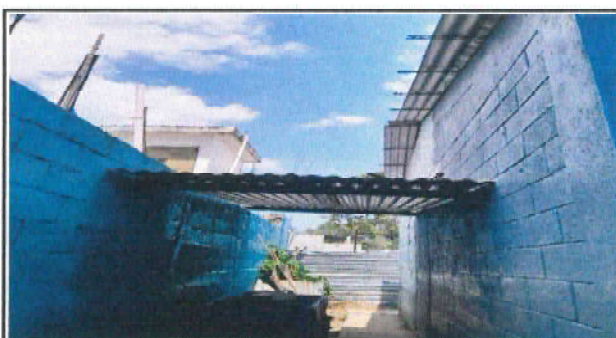
Foto 4: Sustitución de lámina por lámina
