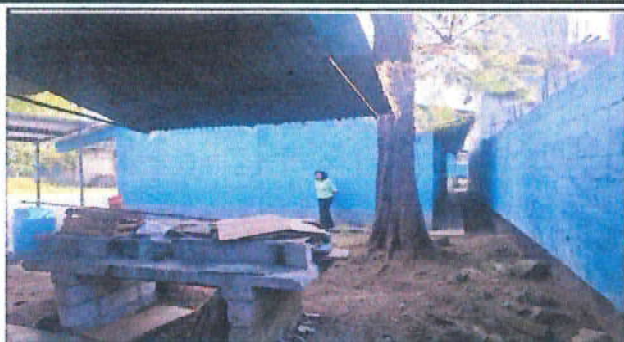
Foto 1: Sustrucción de capote de lámina para lámina troquelada.
