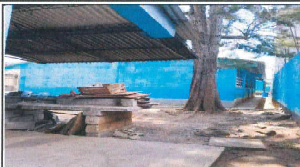
Foto 2: Demoler lo existente para ampliar el pavimento.
