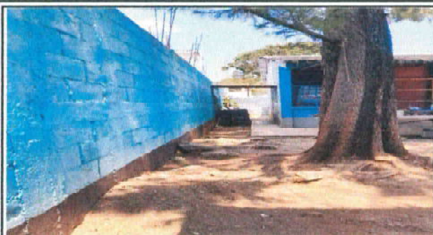
Foto 1: Reparación de muro perimetral al nivel de la pared de la cocina para techar.
