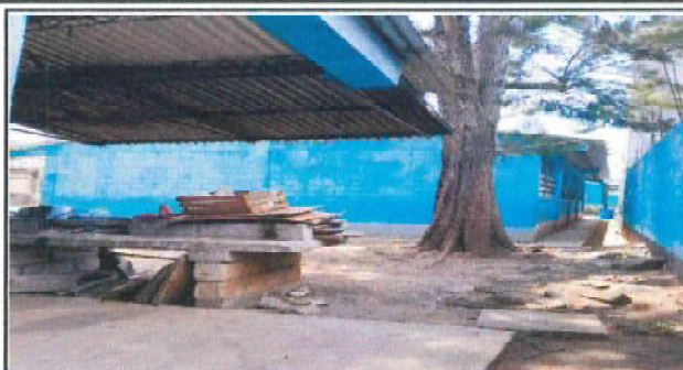
Foto 2: Mantenimiento a reposaderas.
