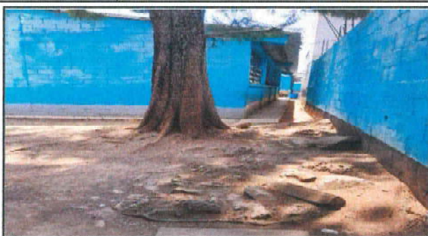
Foto 1: Arreglar el terreno antes de ampliar el pavimento.
