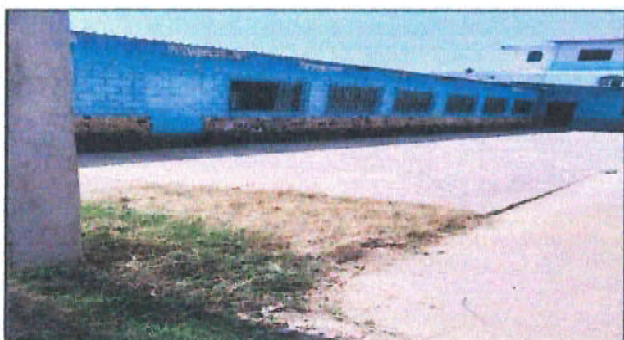
Foto 3: Reparación y ampliación de plancha de concreto en patio central izquierdo de la escuela.
