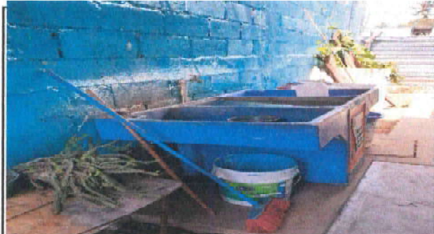
Foto 4: Sustitución de una pila construida con cobertura de 5 toneles debido que solo cae agua una vez por semana y llega a las 4 de la mañana.
