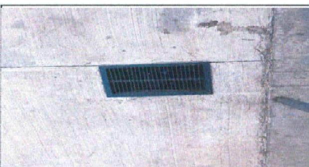
Foto 3: Mantenimiento a cajas de registro.
