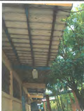
Foto 3: INSTALACIÓN DE CANAL CON DOS BAJADAS
