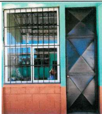
Foto1: Colocacion de chapa a puertas
