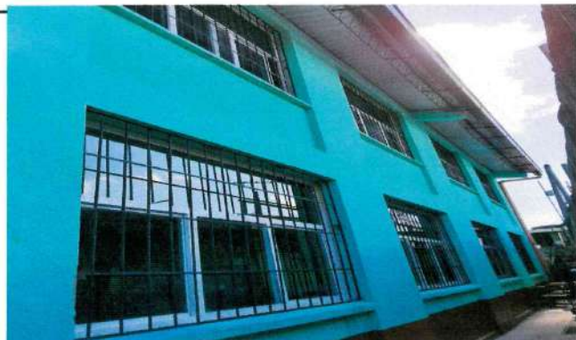
Foto 3: Sustitucion de ventanas de vidrio y colocacion de balcones de metal a cuatro aulas, cocina y bodega
