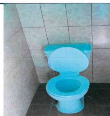
Foto 4: Sustitucion de cinco sanitarios
