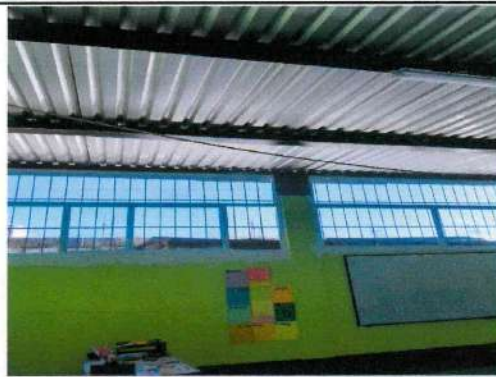
Foto 2: Colocacion de ventanas de vidrio y balcones de metal en dos aulas
