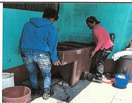
Foto 6: Sustitución de pila plástica
