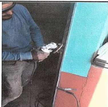
Foto 1: Instalacion de chapas en puertas
