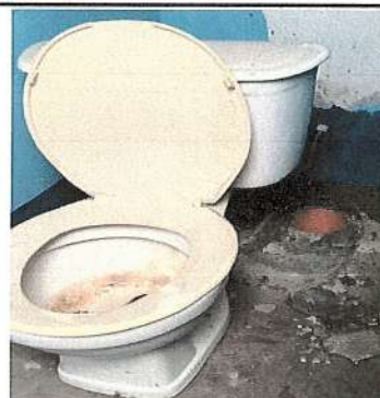
Foto 4: Sustitución de sanitarios
