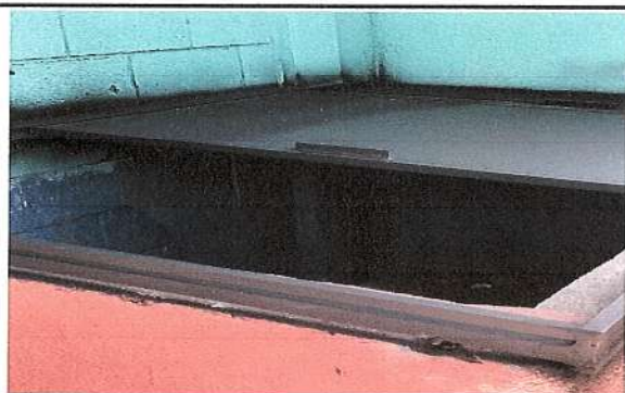
Foto 5: Sustitución de tapadera de metal
