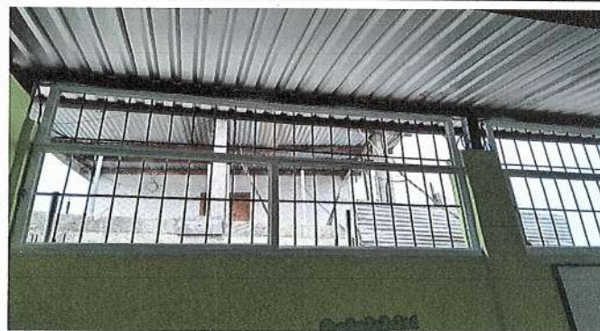
Foto 2: Colocacion de balcones y ventanas de metal
