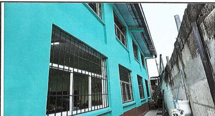
Foto 3: Colocacion de balcones y ventanas de metal
