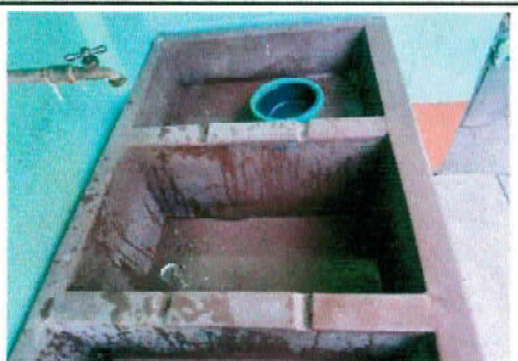
Foto 5: Sustitución y colocación de 1 pila plástica.
