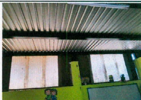
Foto 2: colocación de ventanas de vidrio y balcones de metal a dos salones de clase.
