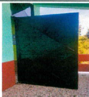
Foto 1: Colocación de chapas a puertas de 5 salones de clase
