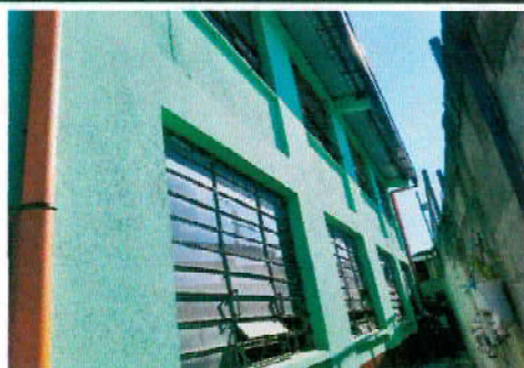
Foto 3: Sustitución de ventanas de vidrio y colocación de balcones a cuatro salones de clase
