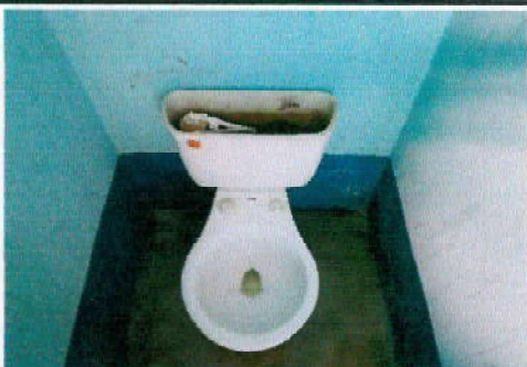
Foto 4: Sustitución de 5 sanitarios
