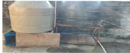
19.25 Fabricación de losa para base de tinacos
