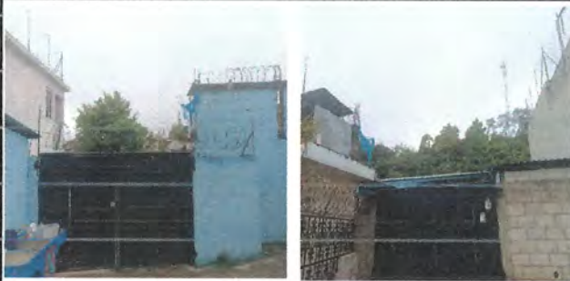
19.26 Instalación de cubierta de lámina troquelada y estructura portante para portón principal
