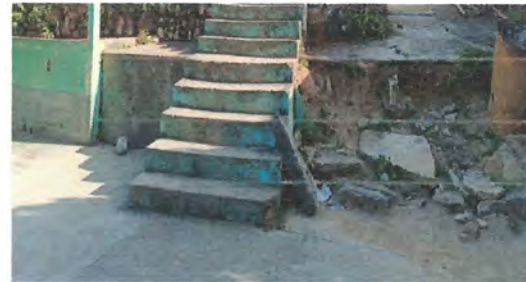
22.1 Reparación de muro de contención
