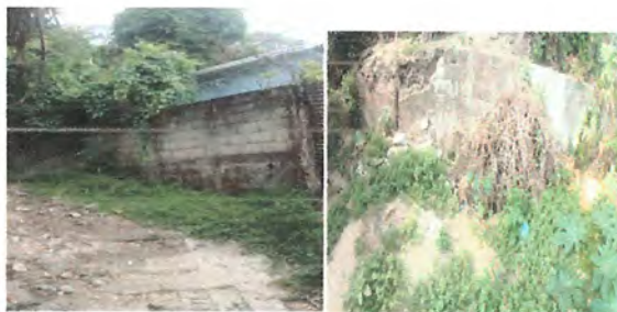
15.2 Reparacion de muro perimetral de block con tubo hg y maya galvanizada, soleras intermedias y columnas
