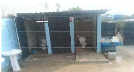
10.3 Desmontaje e instalacion de baños
