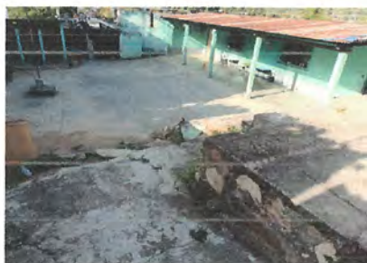
16.1 Reparacion de banqueta de concreto
