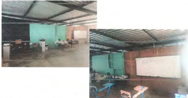
19.24 fabricación e instalación de tabiques para división de salones
