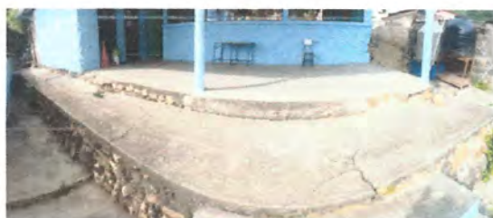
8.2 Reparacion de banqueta de concreto
