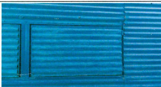
Foto 3: Suministro e instalación de ventanas
