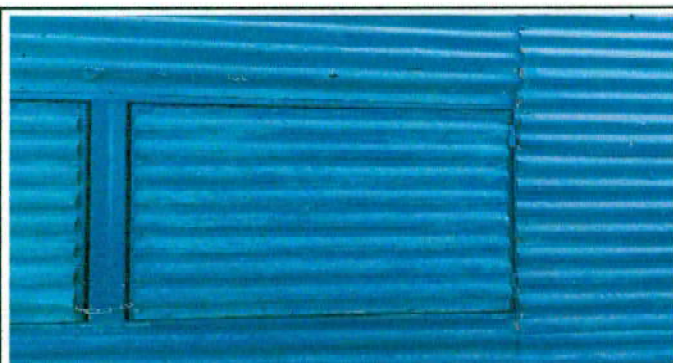
Foto 3: Suministro e instalación de ventanas
