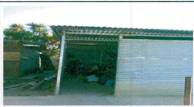
Foto 4: Suministro e instalación de puerta de metal
