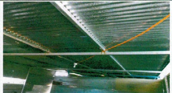
Foto 2: Sustitución de estructura de soporte
