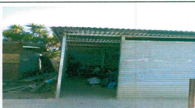
Foto 4: Suministro e instalación de puerta de metal
