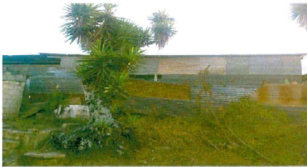
Foto1: Sustitución de lámina por lámina troquelada calibre 26 blanca
