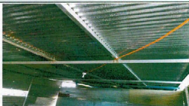
Foto 2: Sustitución de estructura de soporte
