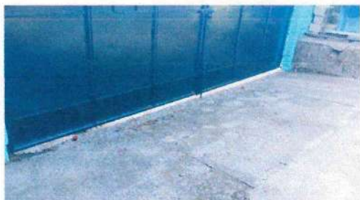
Foto 13: Reparación de portón entrada principal
