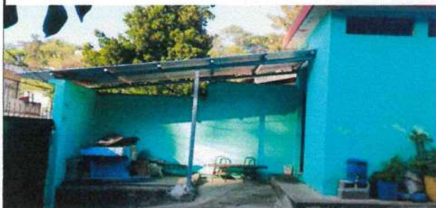
Foto 7: Colocación de estructura y techado
