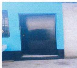
Foto 6: Mantenimiento y pintura a puerta de cocina
