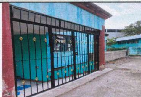
Foto 14: colocación de Portón de reja
