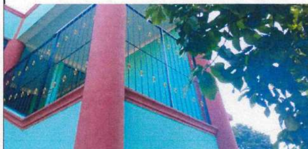
Foto 12: Colocación de Baranda en edificio 2
