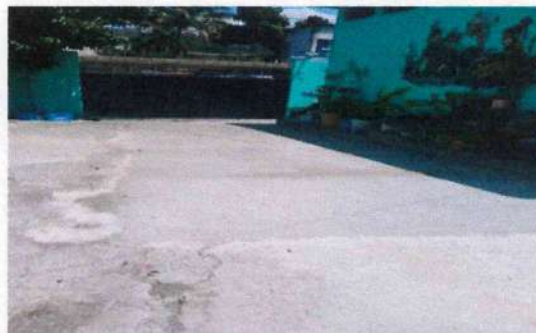
Foto 10: Sustitución de 26 mts2 de torta de cemento dañada
