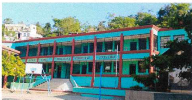
Foto1: Sustitución de baranda por balcones segundo nivel
