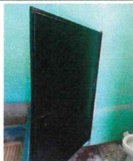
Foto 9: Mantenimiento a puerta de baños de niños
