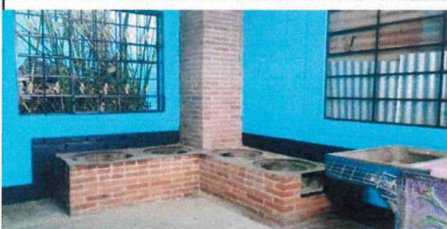
Foto 3: Limpieza de chimenea de cocina
