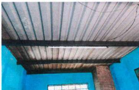
Foto 15: Mantenimiento correctivo a costaneras de cocina
