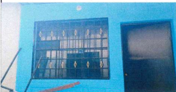
Foto 11: Colocación de balcón en cocina
