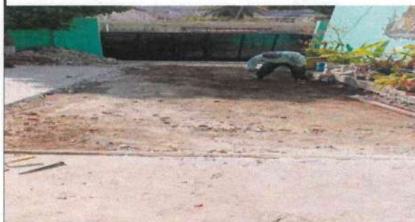
Foto 10: Sustitución de 26 mts2 de torta de cemento dañada
