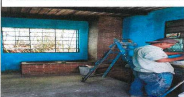
Foto 5: aplicación de pintura en cocina
