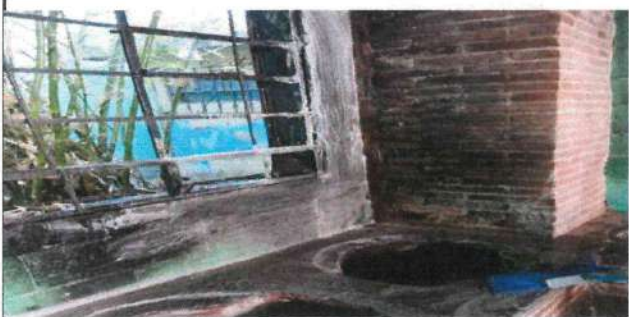
Foto 3: Limpieza de chimenea de cocina
