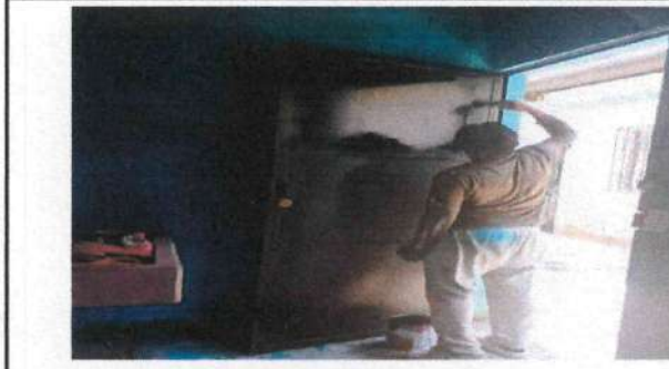
Foto 6: Mantenimiento y pintura a puerta de cocina
