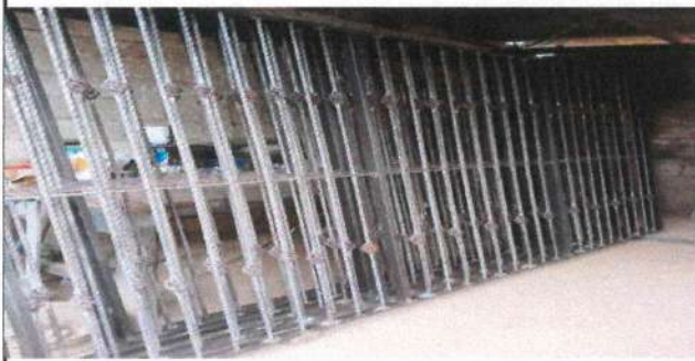
Foto1: Sustrucción de baranda por balcones segundo nivel
