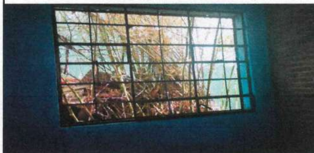
Foto 8: Limpieza y pintura de balcones en cocina
