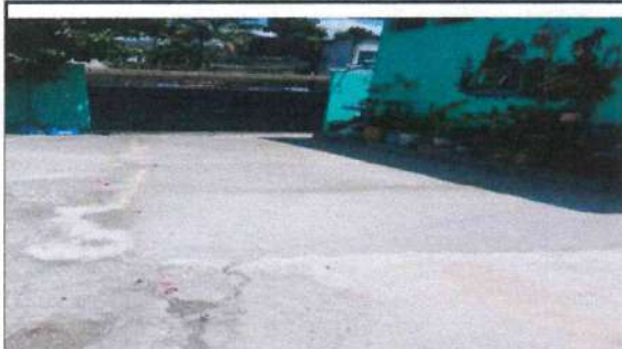
Foto 11: torta de 26 mts2 terminado
