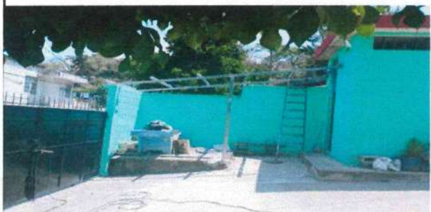
Foto 7: Colocación de estructura para techado
