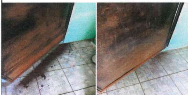
Foto 9: Mantenimiento a puerta de baños de niños
