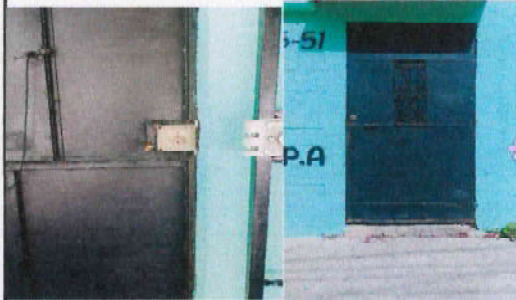
Foto 4: Sustitución de chapa en puerta de entrada principal
