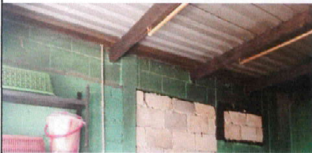
Foto 15: mantenimiento y pintura en costaneras en techo de cocina
