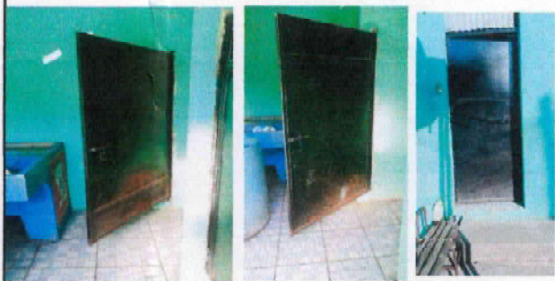
Foto 16: mantenimiento y pintura a puertas de sanitarios planta baja
