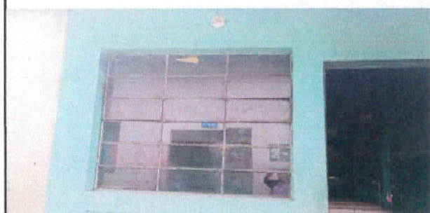
Foto 9: Fabricación e instalacion de balcón en ventana de cocina
