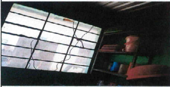
Foto 13: Mejoramiento de electricidad y cambio de tomacorriente en cocina
