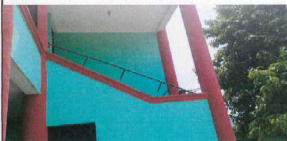
Foto 2: sustitucion de baranda por balcón
