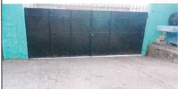
Foto 7: reparación de 6 hojas parte baja de portón principal
