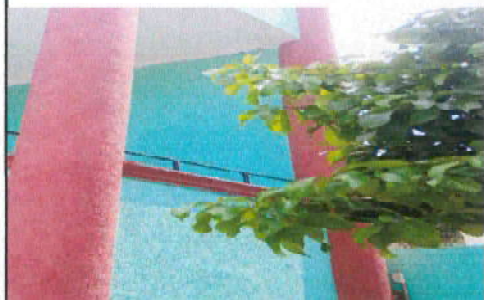
Foto 3: sustitución de baranda por balcón
