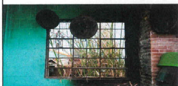
Foto 11: Limpieza y pintura en ventana de cocina, fabricacion e instalacion de balcon
