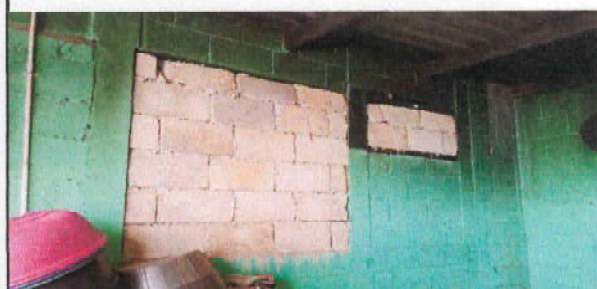
Foto 8: cernido a dos ventanas que fueron cerradas en cocina
