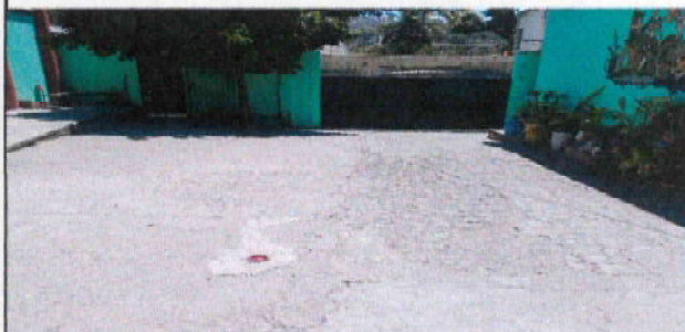
Foto 6: Sustitución de piso de concreto
