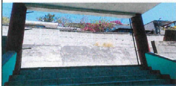
Foto 5: Fabricación y colocación de portón de reja Ingreso principal
