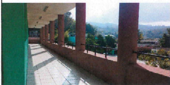
Foto 1: Sustitución de baranda por balcones segundo nivel
