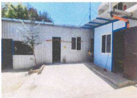
Foto1: Remozamiento de los salones terminado.
