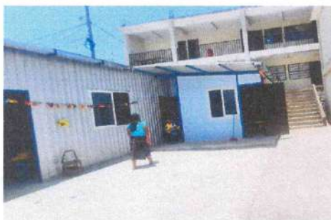
Foto 3: Sustitución de piso. Finalizado
