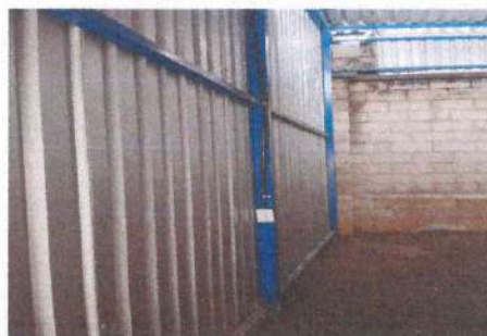
Foto 4: Instalación de tomacorriente terminado.
