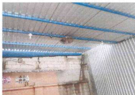
Foto 6: Colocación de bombilla terminado.
