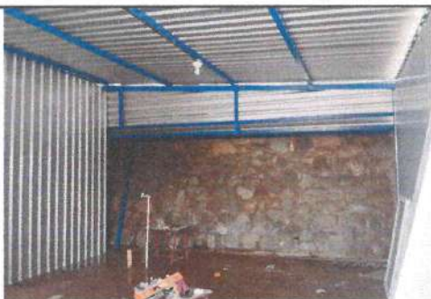
Foto 5: Cubierto de láminas
