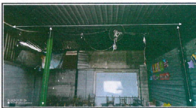
Foto 6: Ampliación, Fabricación e Instalación de estructura portante de metal, area de los salon 1 de Párvulos
