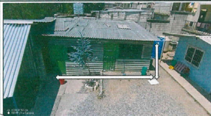
Foto 1: CUBIERTA DE LAMINA : lamina, por lamina troquelada aluzinc calibre 26, en el área de los salones de Párvulos, parte frontal
