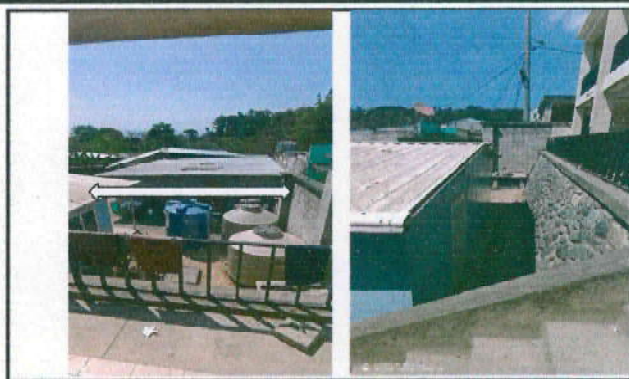
Foto 2: lamina, por lamina troquelada aluzinc calibre 26, en el área de los salones de Párvulos, parte lateral y parte
