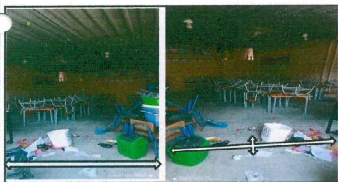
Foto 5: piso de torta de concreto en area de los salon 2 de Párvulos
