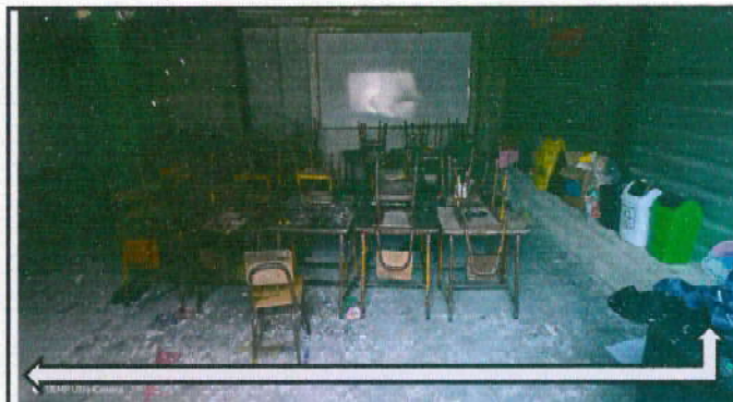
Foto 4: piso de torta de concreto en area de los salon 1 de Párvulos
