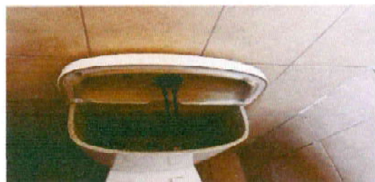
Foto 5: Sustitucion de tanque de inodoro, se cambiaron trece kists de baños push, seis en el primer nivel y siete en el segundo nivel
