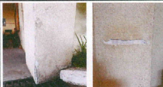
Foto 16: Aplicación y repello de tres columnas que se encuentra agrietas, dos columnas en aulas y una que se encuentra en el taller de mecánica.
