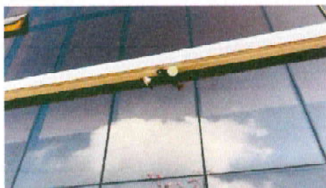
Foto 13: Sustitución de seis reflectores que se encuentran en la fachada del establecimiento.
