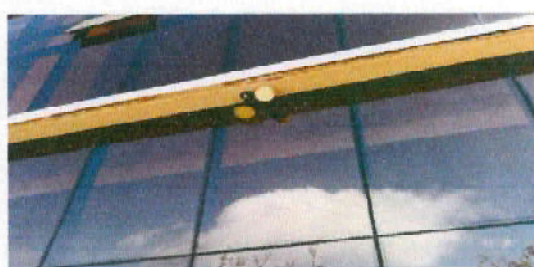
Foto 14: Sustitución de seis reflectores que se encuentran en la fachada del establecimiento.
