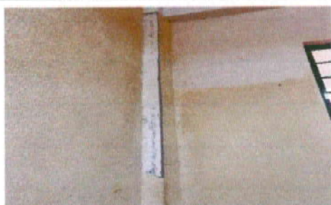
Foto 15: Aplicación y repello de tres columnas que se encuentra agrietas, dos columnas en aulas y una que se encuentra en el taller de mecánica.
