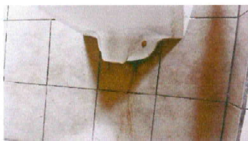
Foto 7: Mantenimiento a dos mingitorios, desmontaje de dos mingitorios, aplicación de sellador para que ya no se filtre el agua.
