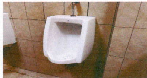
Foto 8: Mantenimiento a dos mingitorios, desmontaje de dos mingitorios, aplicación de sellador para que ya no se filtre el agua.
