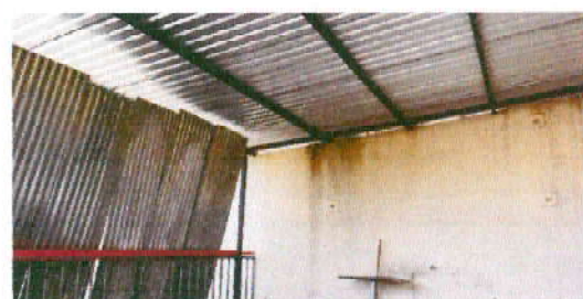
Foto 3: Sustitucion de lámina por lámina troquelada aluzin calibre 26, en galara que se utilizaba para cocinar. Realizacion de estructura y forrado de 46 mts 2 y colocacion de dos ventanas pvc.
