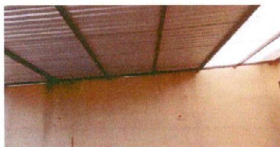
Foto 1: Sustitucion de lámina, por lámina troquelada aluzin calibre 26, Colocacion de nueva estructura de metal e instalacion de lamina aluzin, en el pasillo frente a cuatro aulas.
