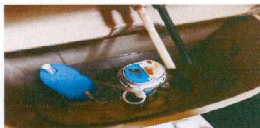
Foto 6: Sustitucion de tanque de inodoro, se cambiaron trece kists de baños push, seis en el primer nivel y siete en el segundo nivel
