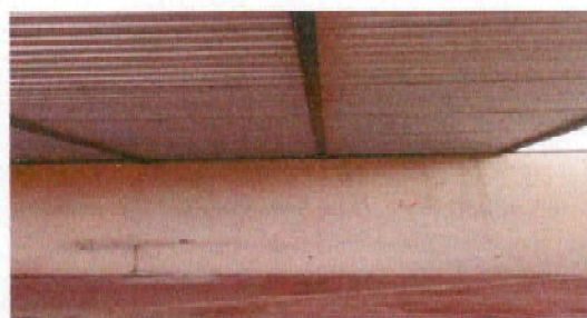
Foto 2: Sustitucion de lámina, por lámina troquelada aluzin calibre 26, Colocacion de nueva estructura de metal e instalacion de lamina aluzin, en el pasillo frente a cuatro aulas.
