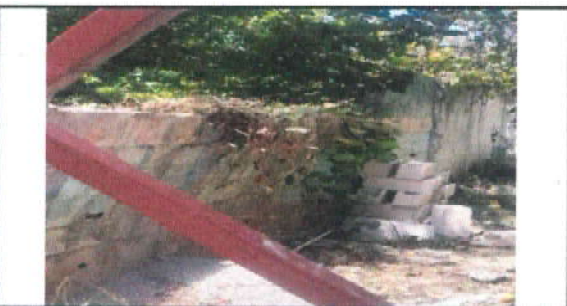
Foto 5: Reparación de muro perimetral dañado
