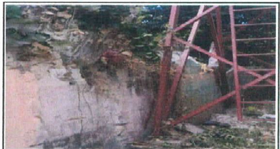
Foto 4: Reparación de muro perimetral dañado
