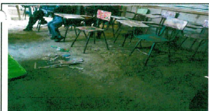
Foto 5: Suministro y realización de piso de concreto
