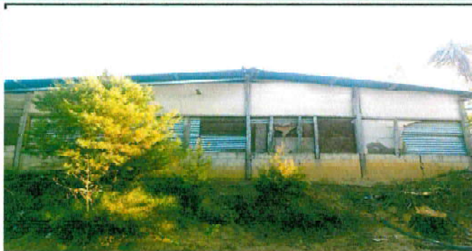
Foto 1: Sustitución de lámina por lámina troquelada calibre 26 blanca
