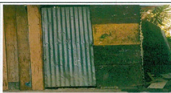
Foto 4: Suministro e instalación de puerta de metal
