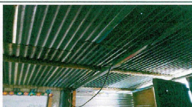
Foto 2: Sustitución de estructura de soporte
