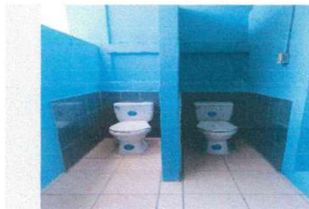
Foto 6: Instalación de inodoros
