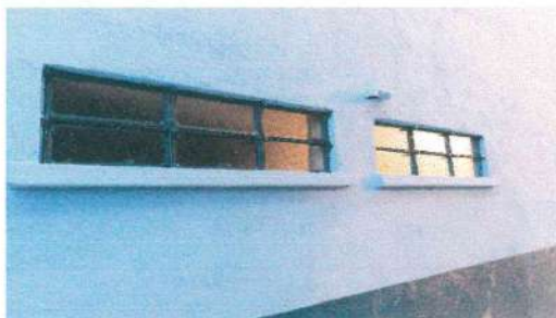
Foto 3: Sustitución de vidrios
