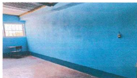
Foto 4: aplicación de pintura de zocalo
