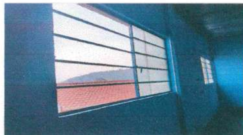
Foto 2: Sustitución de estructura de metal de ventana
